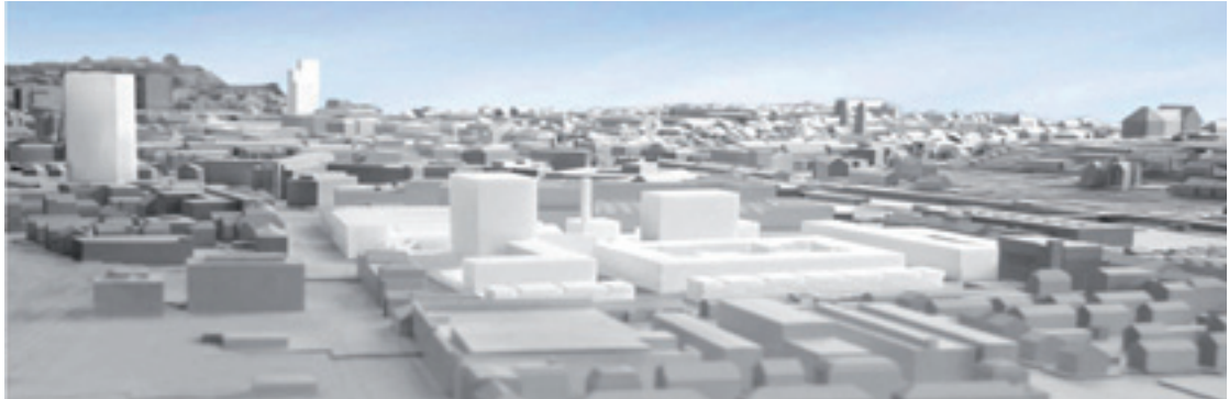
Auf dem Werk 1 im Sulzerareal Stadtmittte wird in einer Testplanung nach dem optimalen Rahmen für eine Umnutzung gesucht.
