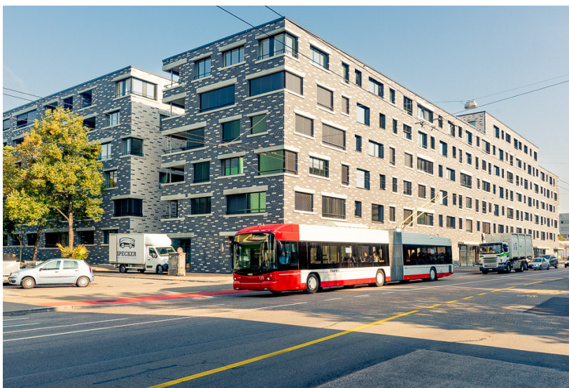
Neubau Werk 3, Zürcherstrasse © Stadtentwicklung Winterthur
