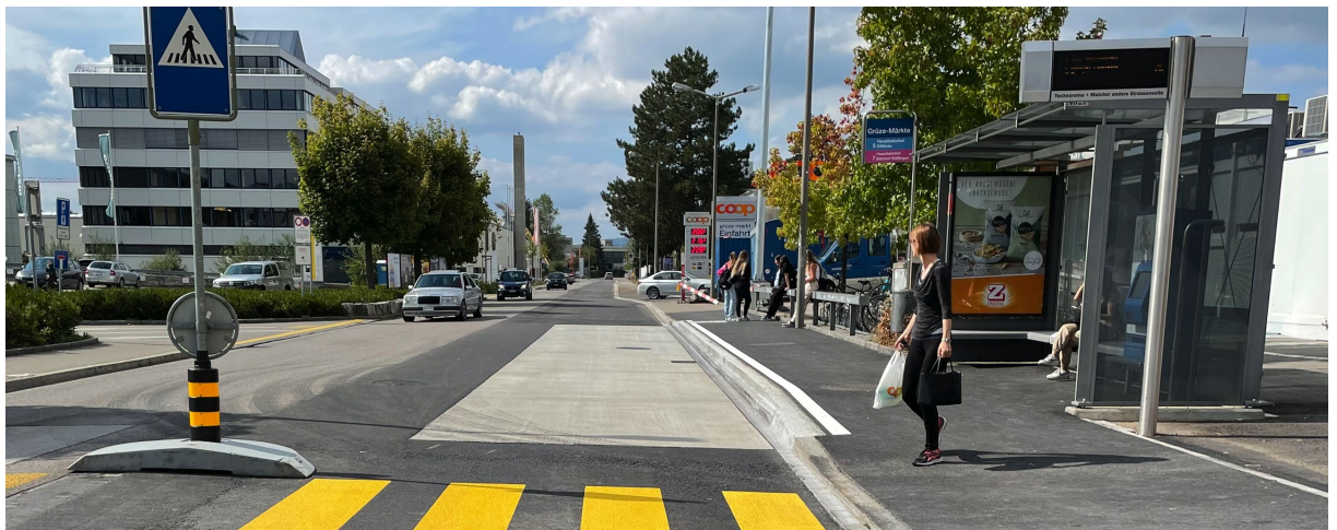
Abbildung 2: Haltestelle Grütze-Märkte mit Zürich-Bordstein 22 cm
