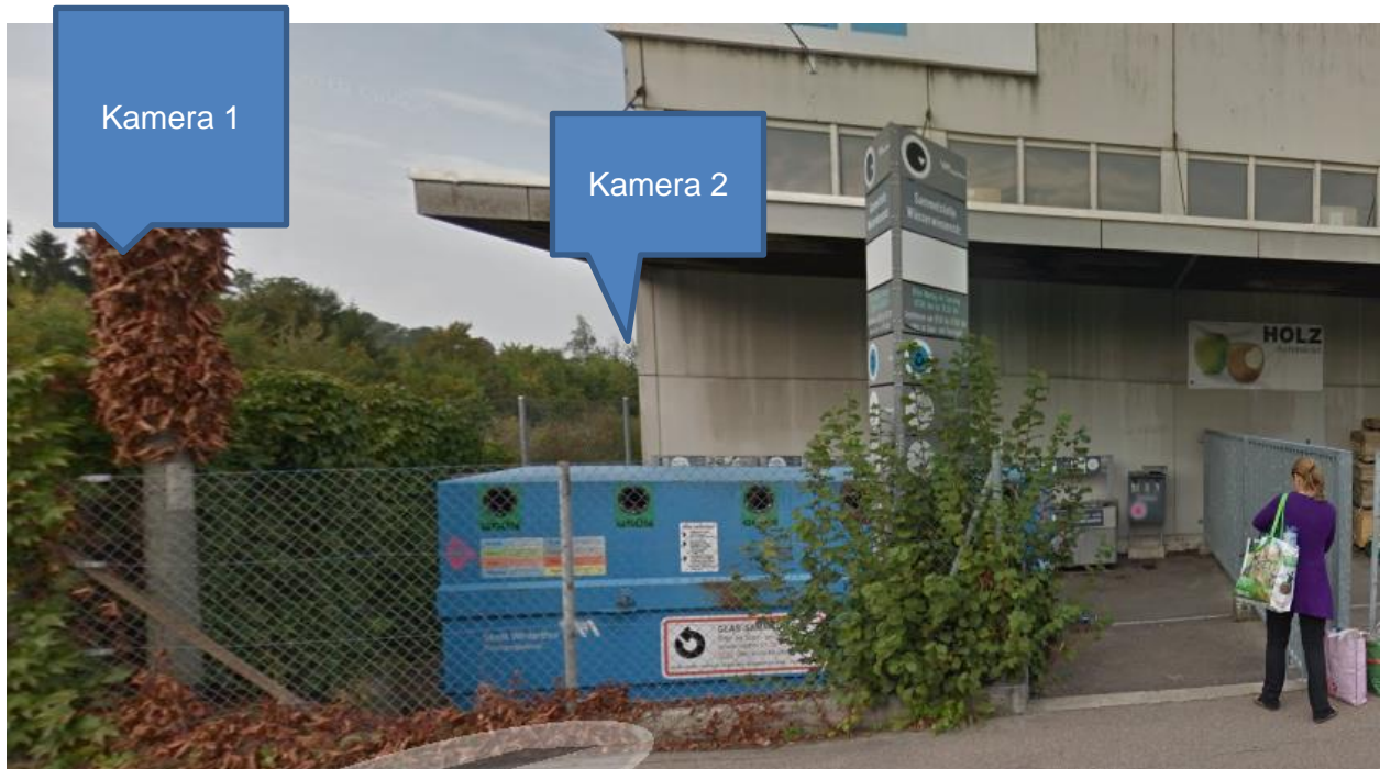
Kamera 1: Montage an den Kandelaber mit Sichtfeld auf die Wässerwiesenstrasse Kamera 2: Montage an der Zaunstange (Verlängerung Rohr) Sichtfeld Containerplatz
