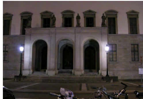
18 Museum Oskar Reinhart: Kandelaber beleuchten die Fassade mit, Inszenierung fehlt, undifferenzierte Grund- und Architekturbeleuchtung (-)
