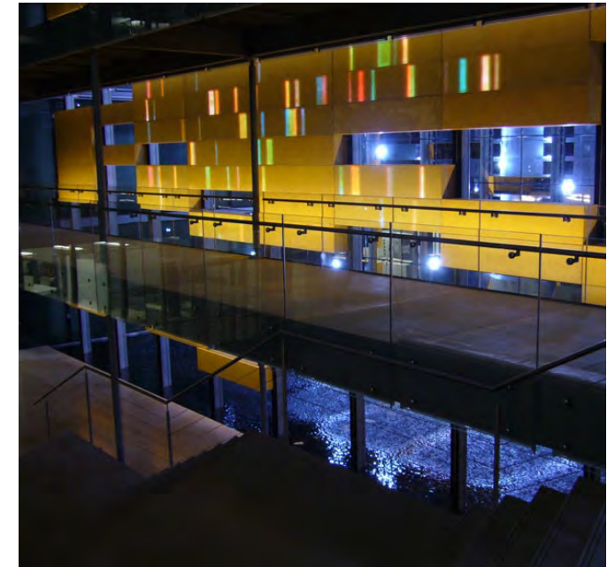
Holografische Folien auf beleuchteten Glasfassaden ändern ihr Erscheinungsbild bei unterschiedlichen Betrachtungswinkeln.
