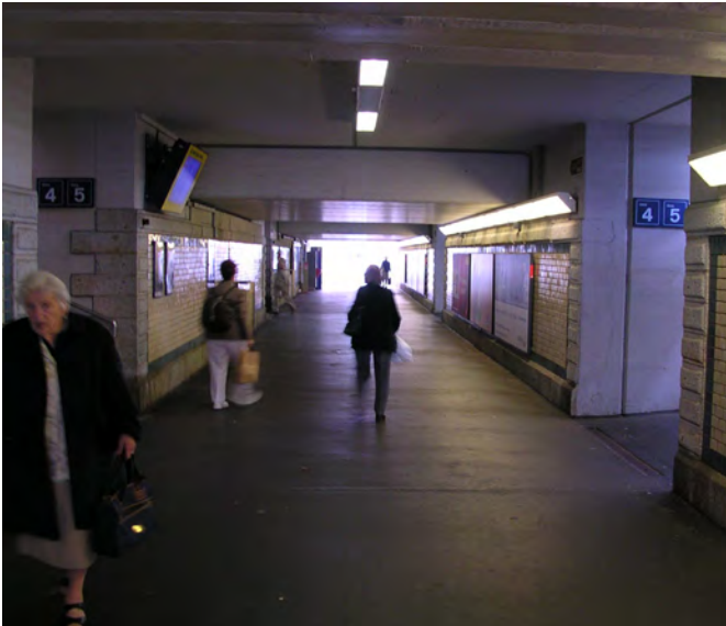
Unterführung Hauptbahnhof, funktionale Mindestausleuchtung (-)
