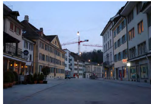
23 Neumarkt: Ähnliches Beleuchtungsprinzip wie in den Altstadtgassen, fehlende Herausarbeitung des Platzes mit Licht
