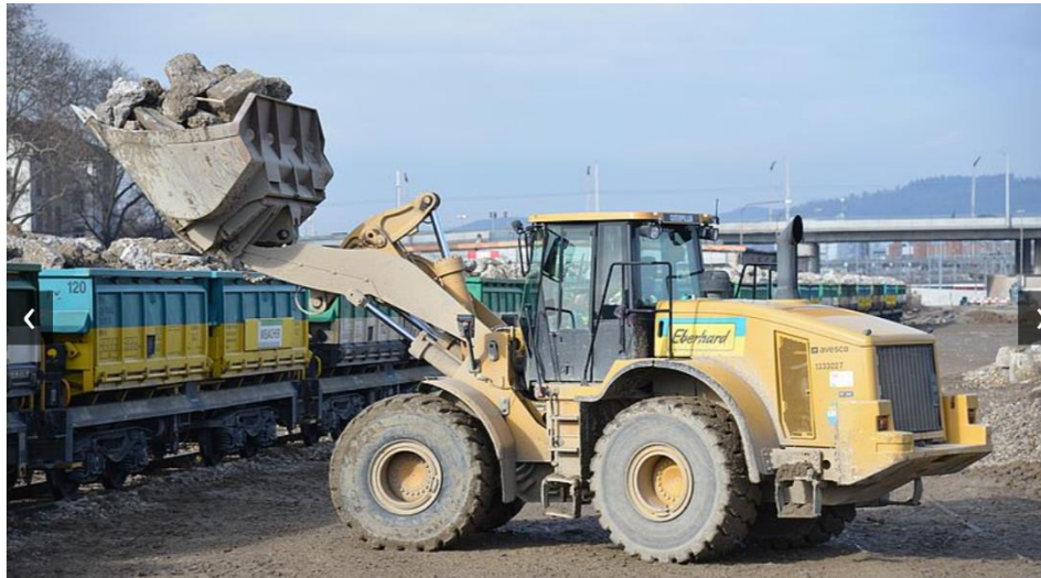
Abbildung 28 City-Hub für Aushubmaterialien (Massengüter) (Quelle Bild: www.eberhard.ch )
