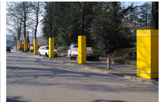
Abb. 08: Stammschutz während Strassensanierungsarbeiten an der Haldenstrasse
