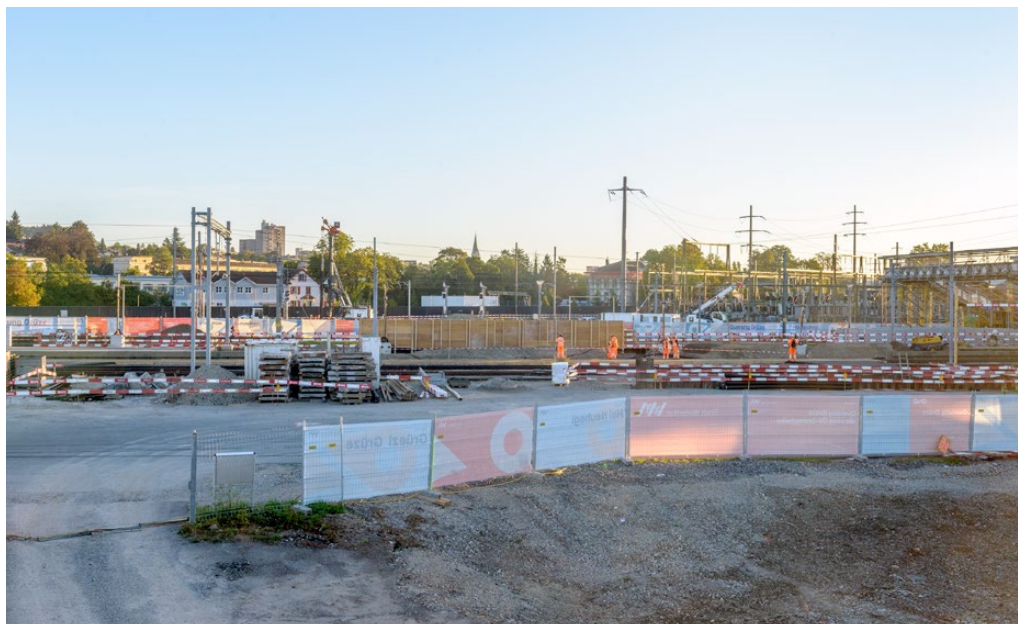
Baustelle Leonie-Moser-Brücke (Arnold Kohler)
