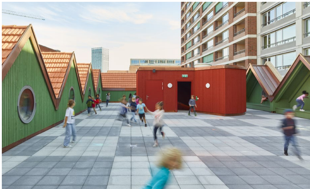
Kindergarten und Primarschule Lokstadt (Arnold Kohler)
