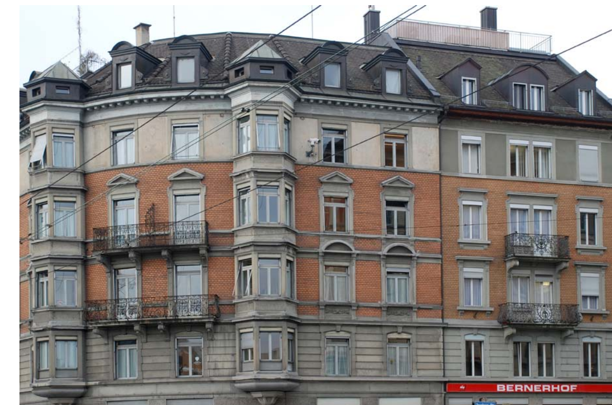
Aufstockung Zeughausstrasse, Zürich
