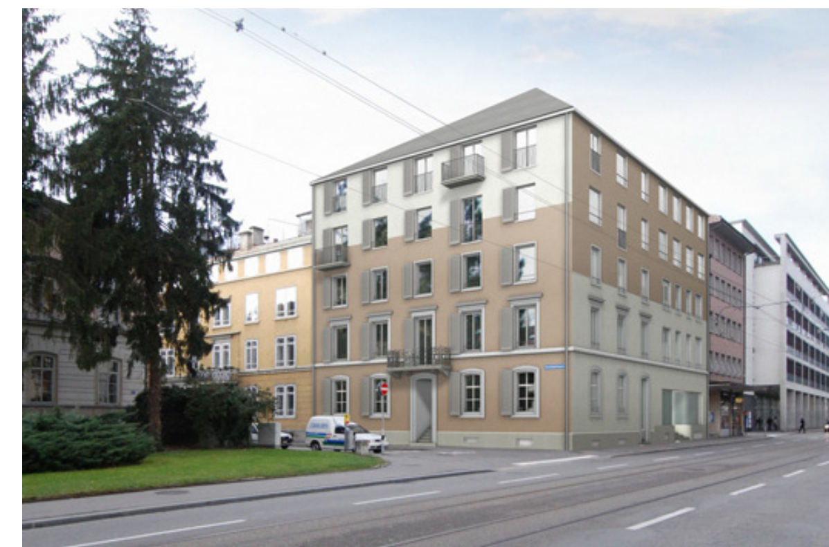
Aufstockung Stockerstrasse, Zürich (Park Architekten)
