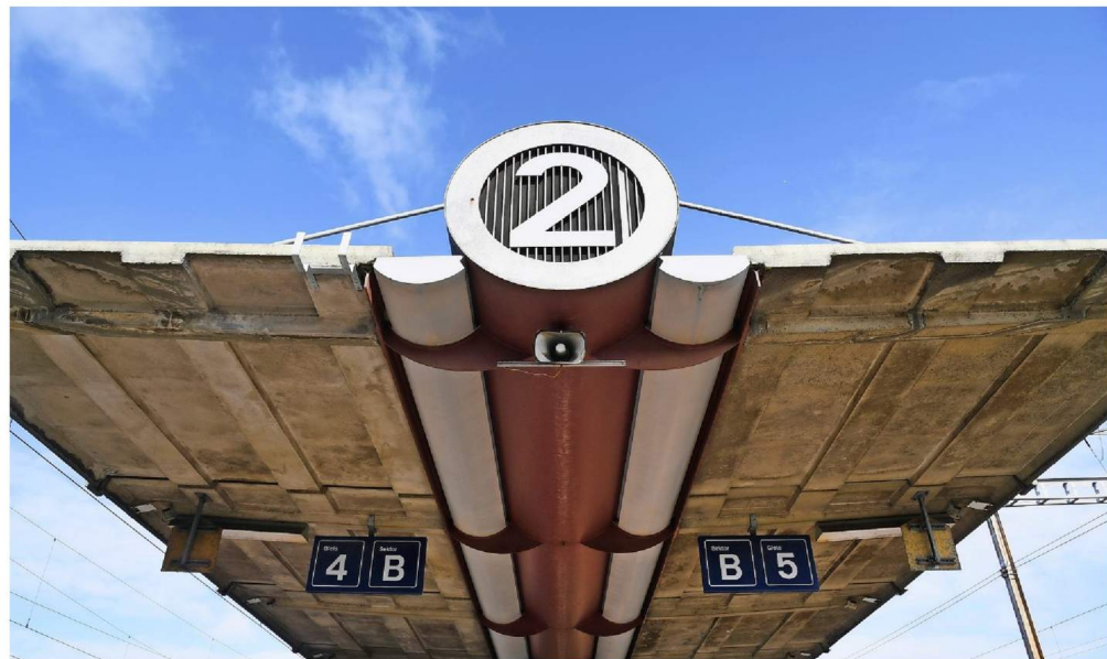
Die Perronanlage des Grüze-Bahnhofs steht unter Denkmalschutz, auch das zentrale Tragrohr des Perrondachs mit der (alten) Perronnummer an der Stirnseite. Foto: Madeleine Schoder
