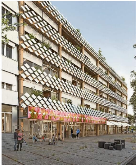
Fotovoltaikpanels ziehen sich wie Bänder entlang des neuen Holzbau. Das dreistöckige Foyer ist dessen Herz. Visualisierungen: Maars Visualisierungen
