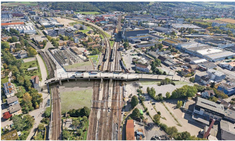
2023 ist Baubeginn für die 390 Meter lange Busbrücke über das Gleisfeld beim Bahnhof Grütze. Visualisierung: PD
