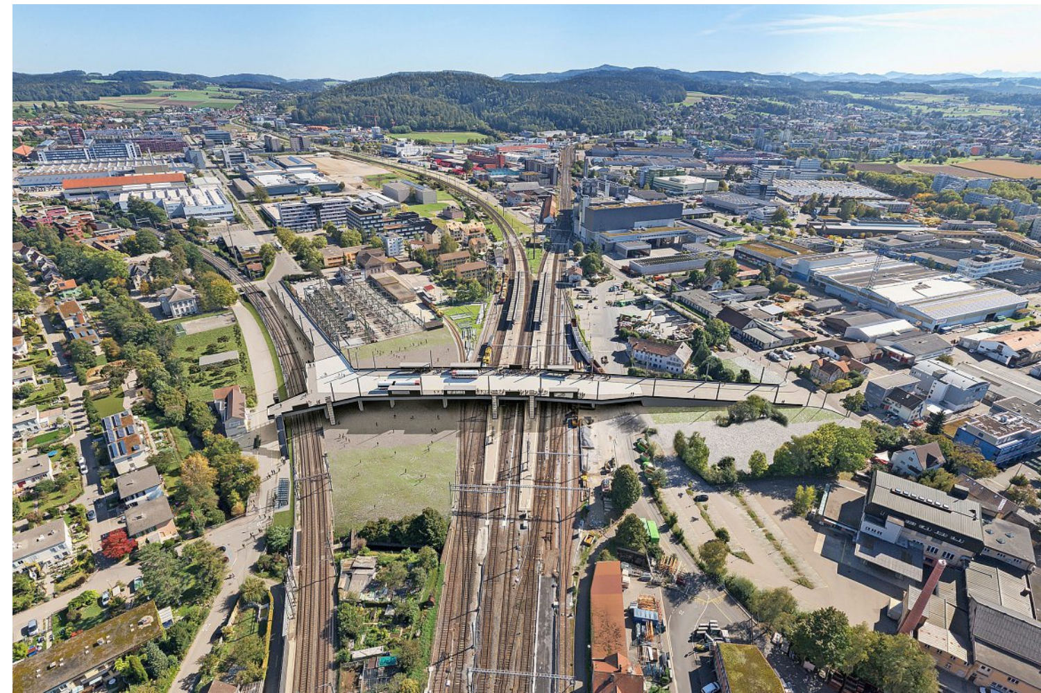
Eine Brücke, die auch ein städtischer Platz und eine Bushaltestelle ist: So könnte die Querung Grüze ab 2026 aussehen. Links im Bild die neue Haltestelle Grüze-Nord (ab ca. 2035). Visualisierung: PD / Stadt Winterthur
