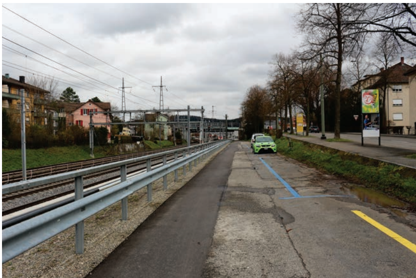
Führung der VSR 2 entlang der Gleise parallel zur Römerstrasse: die Parkierung wird aufgehoben und der Belag ersetzt.
