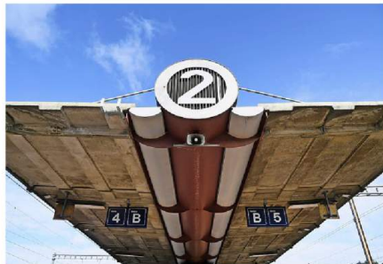
Die Perrondächer von Hans Hilfiker sind denkmalgeschützt. Foto: M. Schoder
