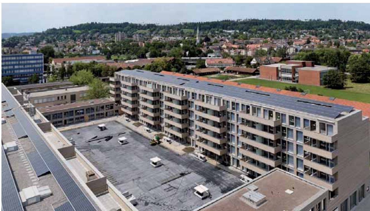
Abbildung 33 Blick auf die Photovoltaik-Anlage (Quelle: Allreal).
