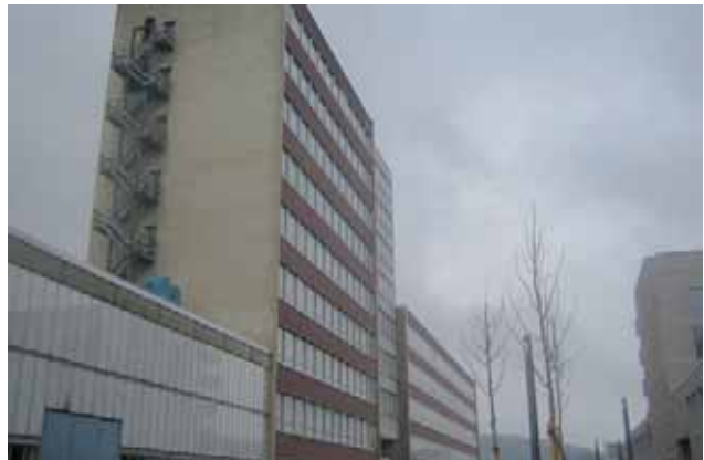
Abbildung 8 Nachbargebäude östlich zum Eulachhof, Else-Züblin-Strasse.
