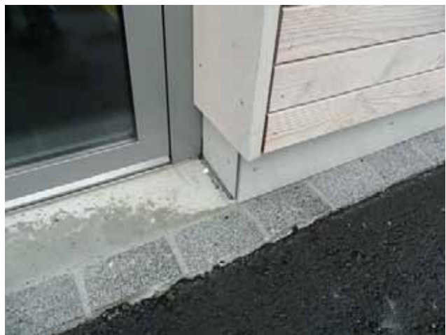
Abbildung 44 Sockelanschluss Strassenseite.
