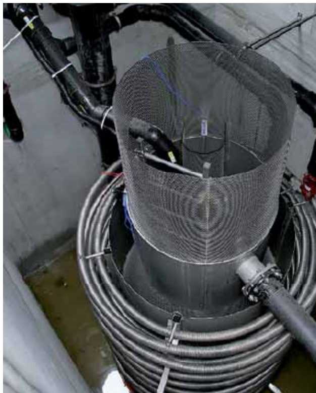
Abbildung 26 FEKA-Modul / Wärmetauscher im Eulachhof (Quelle Foto: Spektrum der Gebäudetechnik, 3/2007).
