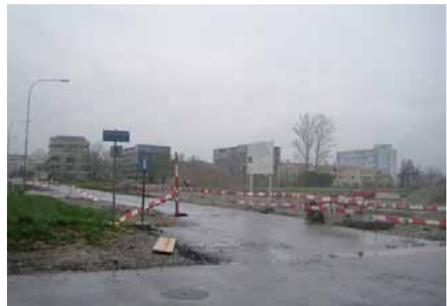
Abbildung 5 Hier entsteht der Eulachpark.
