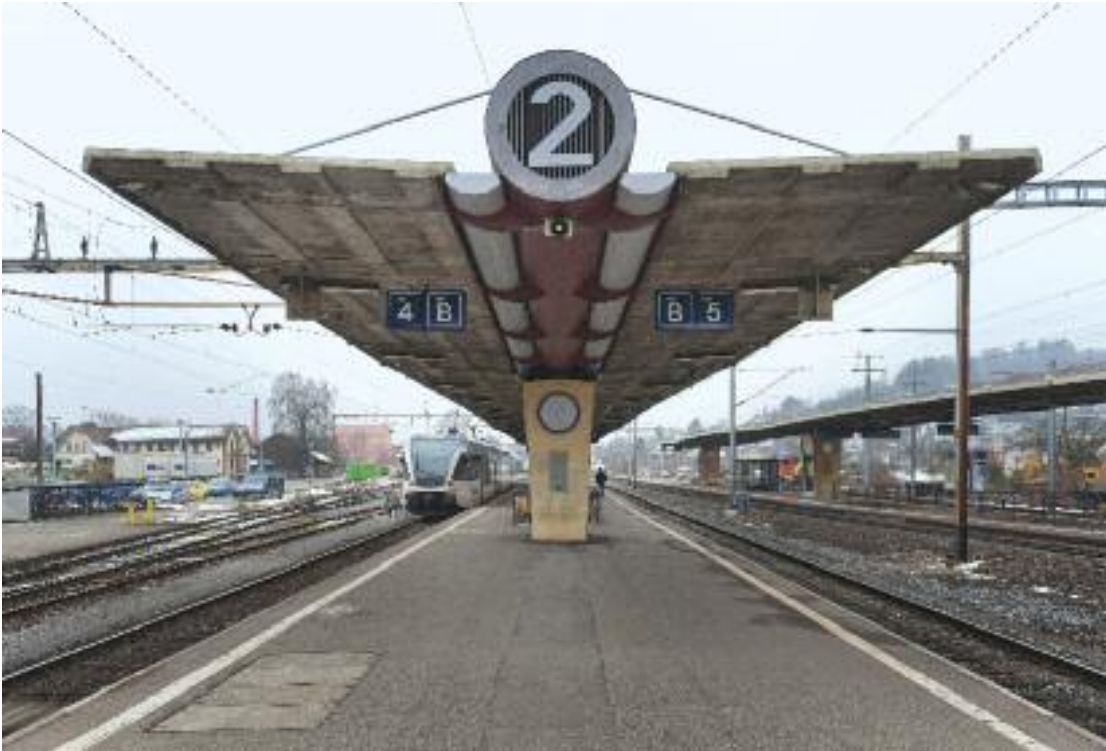
50er-Jahre am Bahnhof Grütze: Die einzigartigen Rohr- träger-Perrondächer wurden 1955 vom Archi- tekten Hans Hilfiker als Prototypen erstellt.
