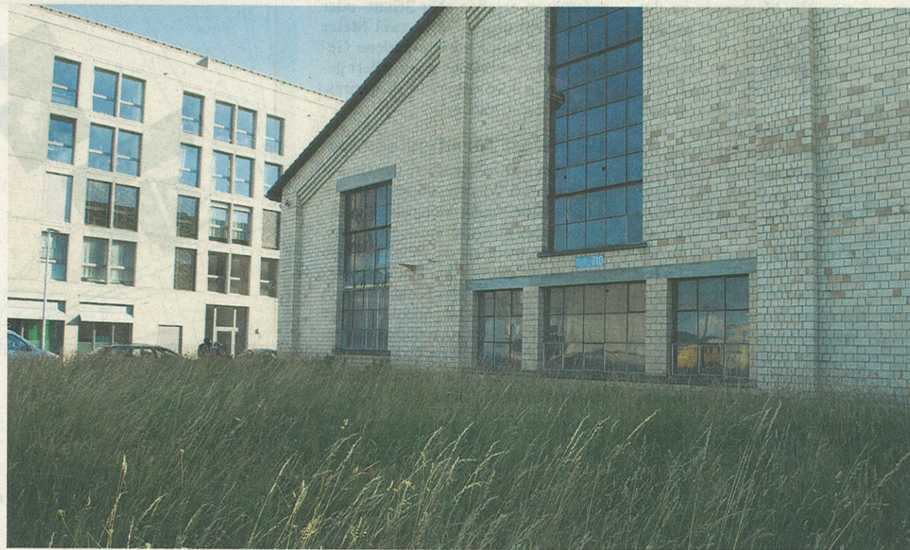
Gegenstück und Ergänzung zu den neuen Wohnbauten: Die Halle 710 behält ihren industriellen Charakter. Bild: Andreas Wolfensberger
