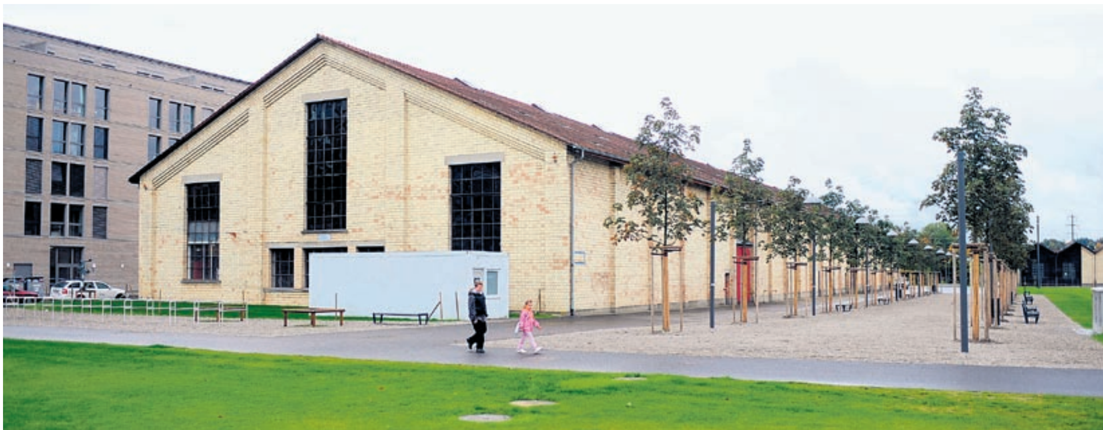
Die alte Sulzer-Lagerhalle 710 am Eulachpark ist rund 115 Meter lang. An ihrer Ostseite (Bild) soll ein Bistro entstehen mit Glastüren gegen den baumgesäumten Pétanqueplatz hin (rechts). Bild: Marc Dahinden
