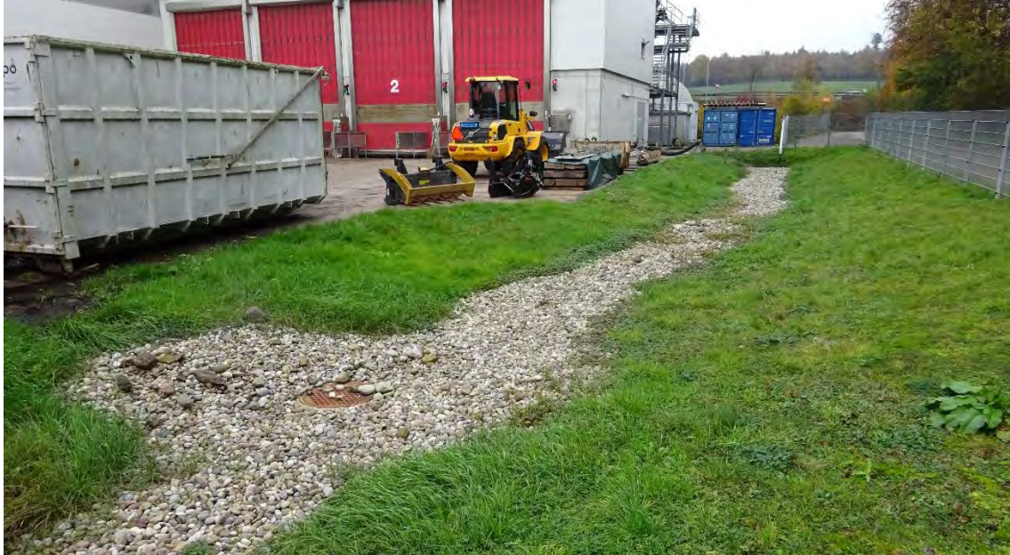
Abbildung 16: Versickerungsanlage im östlichen Arealteil (Quelle: Ecosens)
