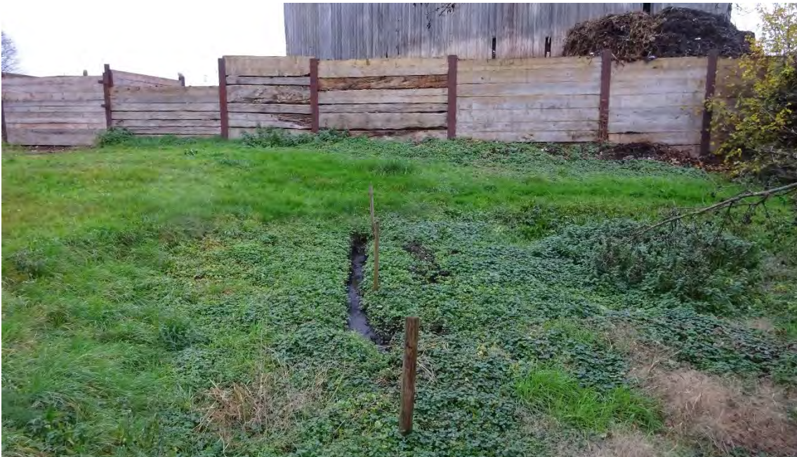
Abbildung 17: Versickerungsanlage im westlichen Arealteil (Quelle: Ecosens)
