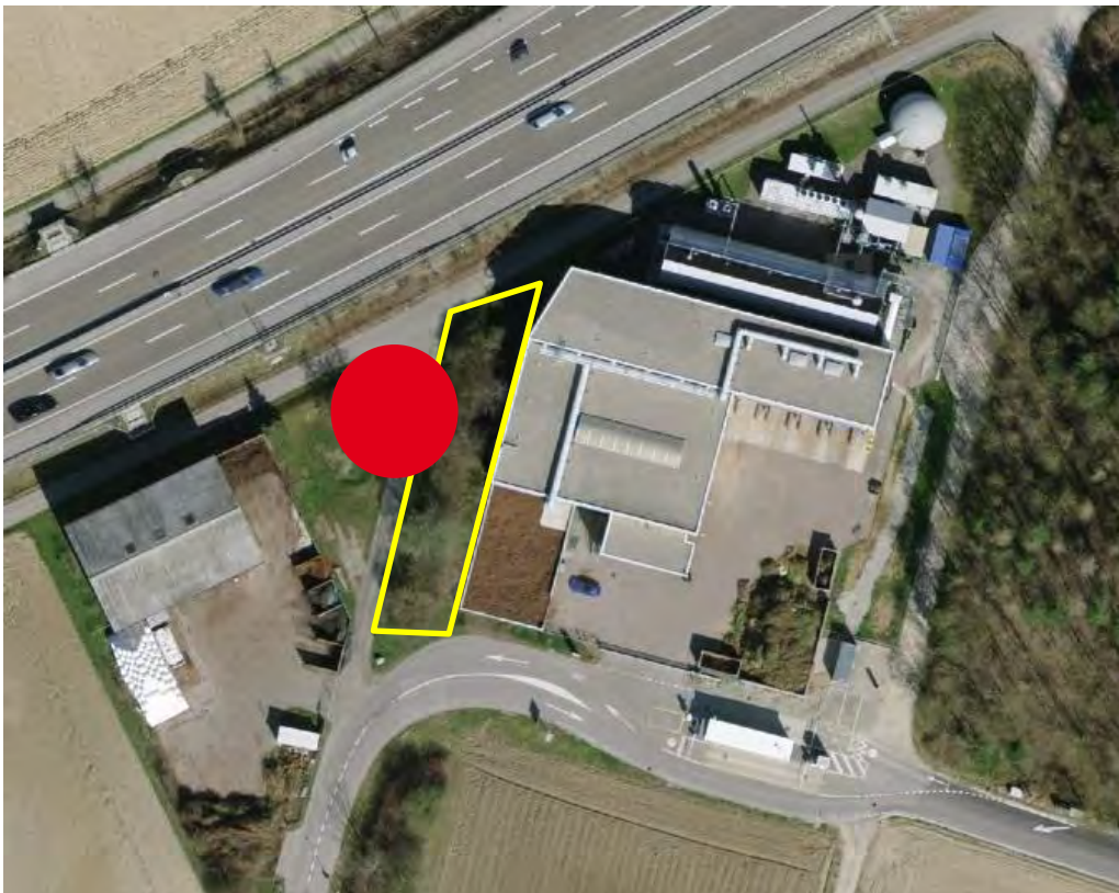
Abb.1.1 Bestehende Vergärungsanlage in Winterthur, mit dem Standort der Hecke, welche im Rahmen der bevorstehenden Bauarbeiten entfernt werden muss (gelb) und dem ungefähren Standort des PWT (rot).
