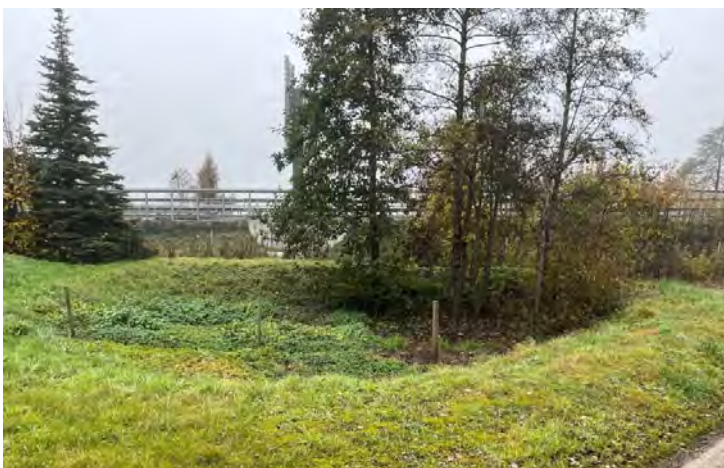
Abb. 3.4 Bestehendes Retentionsbecken mit Bepflanzung.
