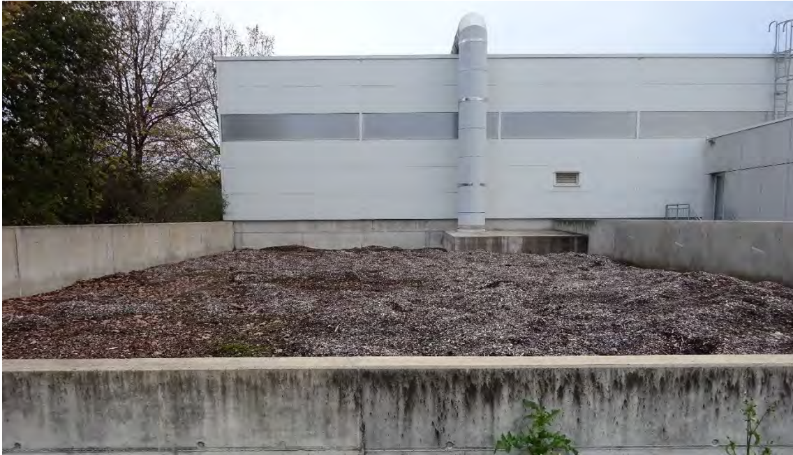
Abbildung 7: Flächenbiofilter (Quelle: Ecosens)
