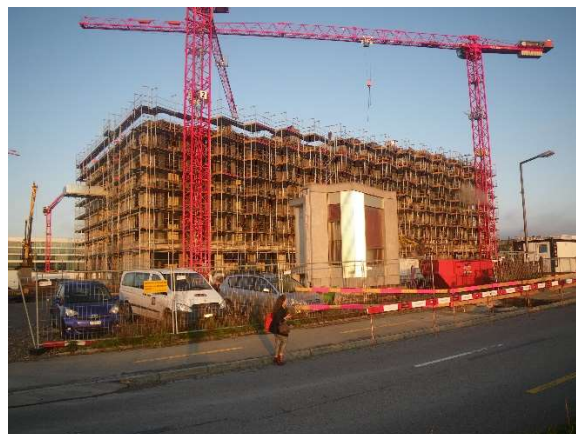
Abbildung 11: Überbauung Baufeld 3 (Seniorenzentrum "Vivale Neuhegi")
