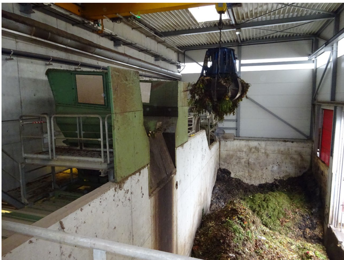
Abbildung 4: Tiefenbunker mit Krananlage (Foto: Ecosens)
