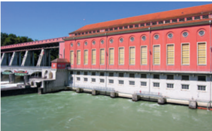
Eglisau: Historisches Kraftwerk, 1915–1920, Gebrüder Pfister | Bild: Archäologie und Denkmalpflege Kanton Zürich
