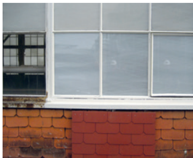
City Halle, Fassadendetail | Bild: Amt für Städtebau
