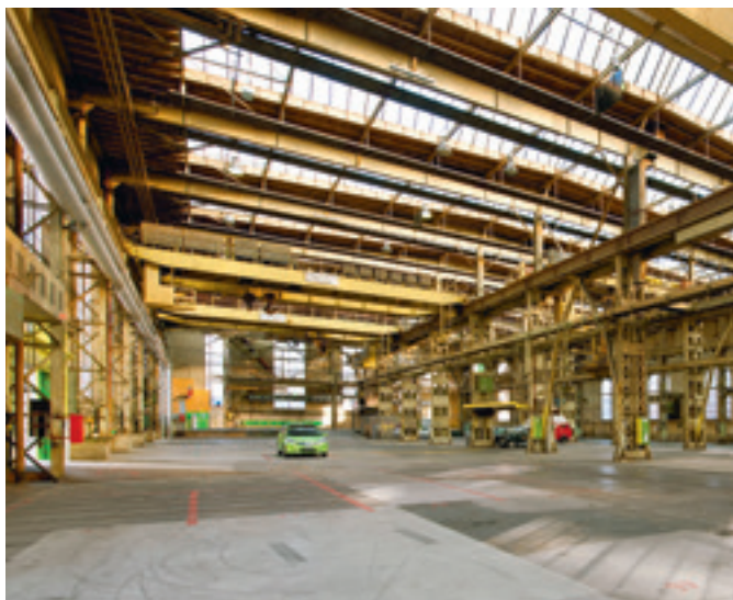
Halle 53, Innenansicht | Bild: Implenia, Alessandro della Bella
