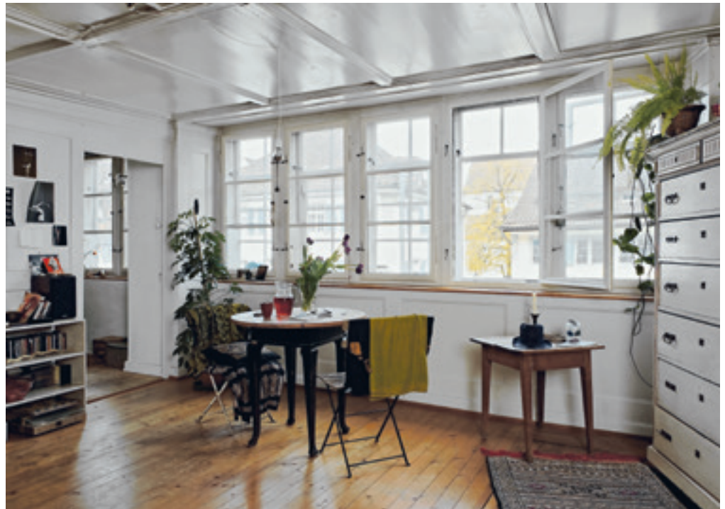
Historische Fenster boten oft differenzierte Lüftungsmöglichkeiten, beispielsweise mit einem kleineren oberen Kippflügel oder Winter- und Sommerfenster. | Bild: Christian Schwager
