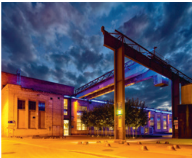
Halle 53, Aussenansicht | Bild: Implenia, Alessandro della Bella
