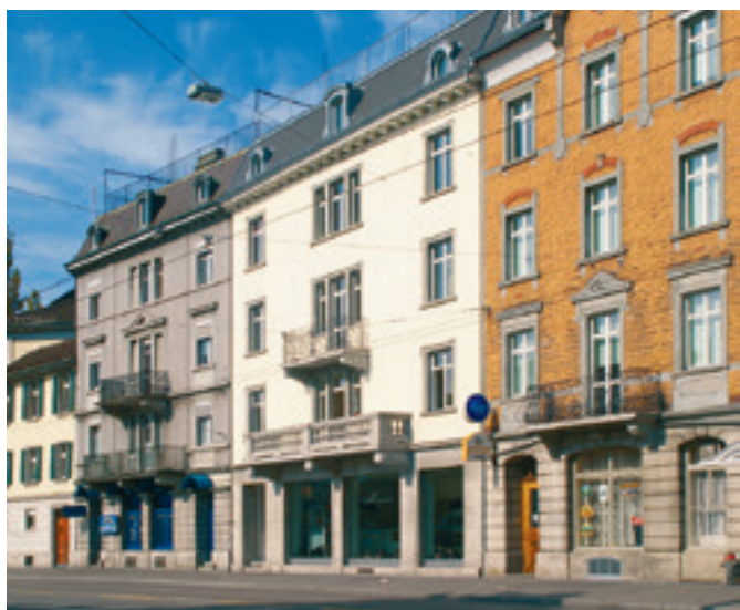
Altstadthaus Technikumstrasse 98, saniert im Minergie-Standart | Bild: Amt für Städtebau Winterthur
