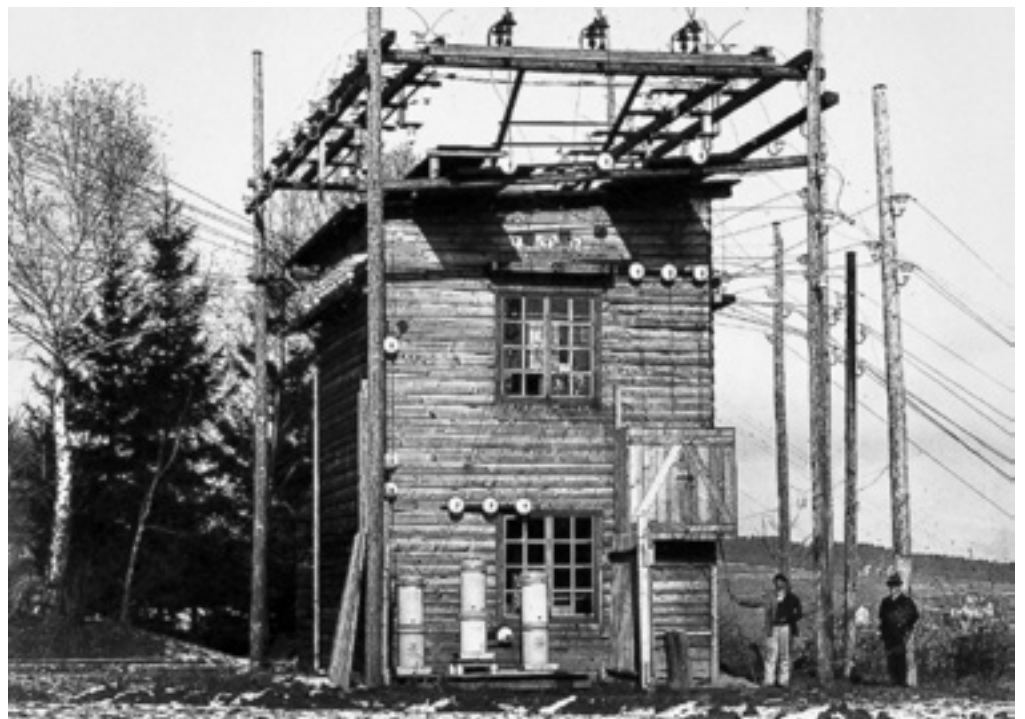
Trafostation 1908, Provisorium im Hündler | Bild: Winterthurer Bibliotheken, Studienbibliothek
