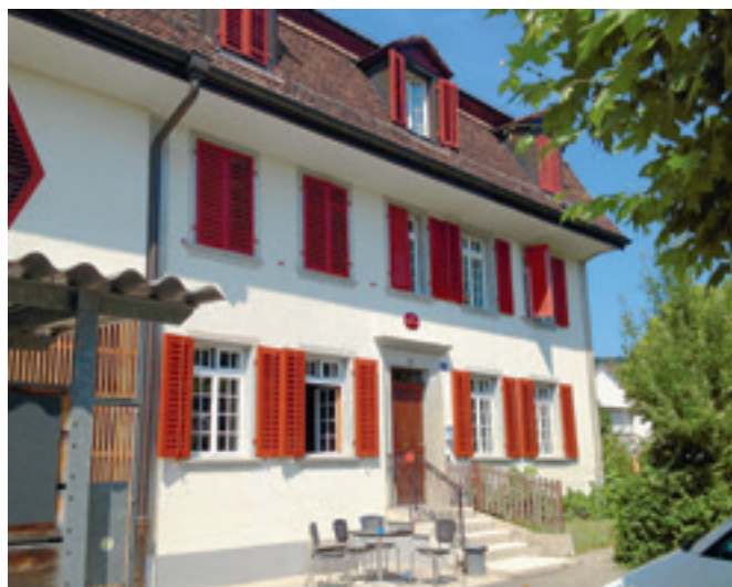
«Zum Neuen Haus», nach den Renovationsarbeiten | Bild: Denkmalpflege Winterthur
