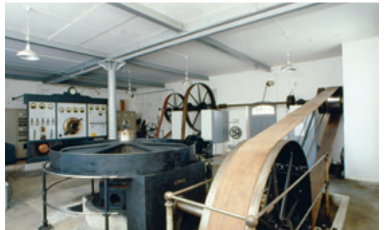
Ottenbach: Historisches Kleinkraftwerk | Bild: Archäologie und Denkmalpflege Kanton Zürich
