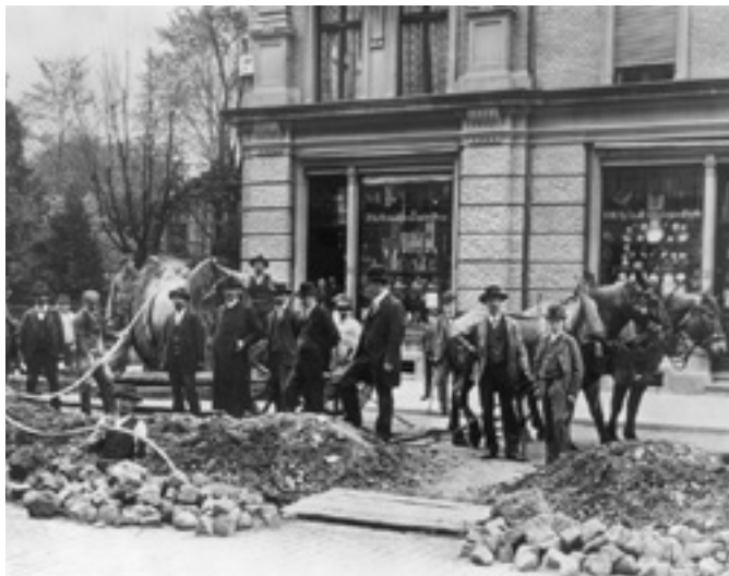
Kabelverlegen, Stadthausstrasse um 1910 | Bild: Winterthurer Bibliotheken, Studienbibliothek
