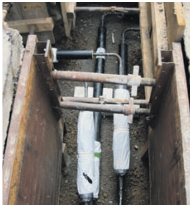
Fernwärmeinstallation im Boden der Altstadt von Winterthur. | Foto: Roger Isler
