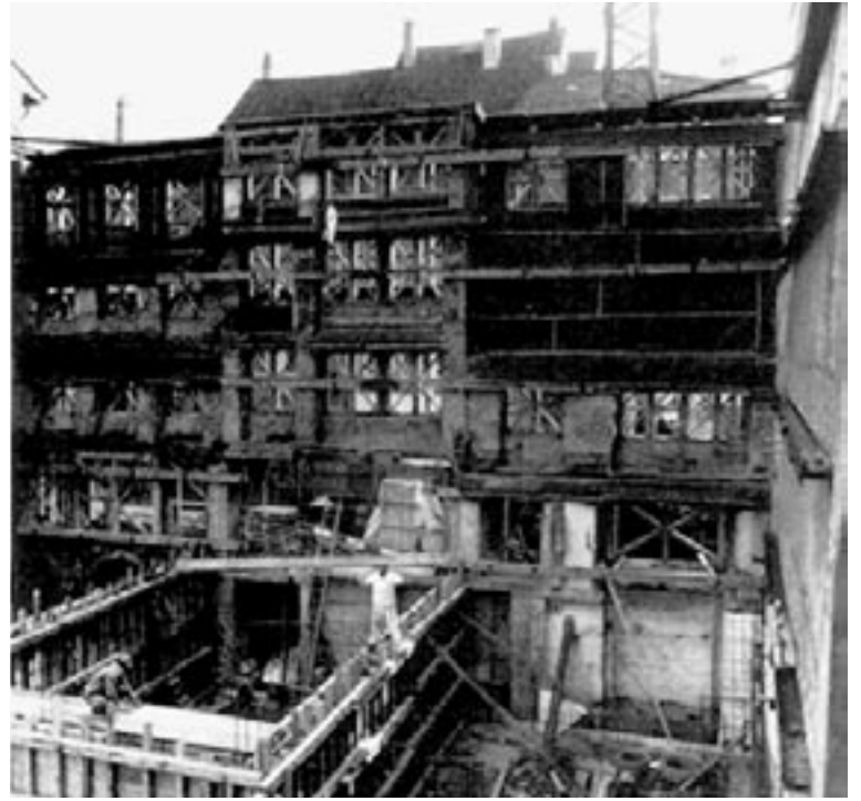
▲ Nach 1975 entstand hinter diesen historischen Fassaden am Obertor das Zentrum Obertor als vollständiger Neubau. | Foto: Winterthurer Bibliotheken, Sondersammlungen
