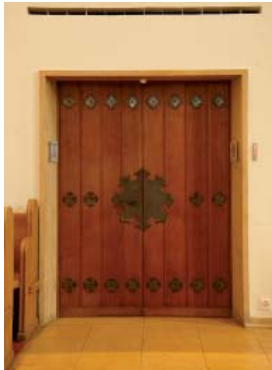
Die Holztürlügel sind mit Metallblechen beschlagen, deren Ornamentik sich an der frühmittelalterlichen Formensprache orientiert.
