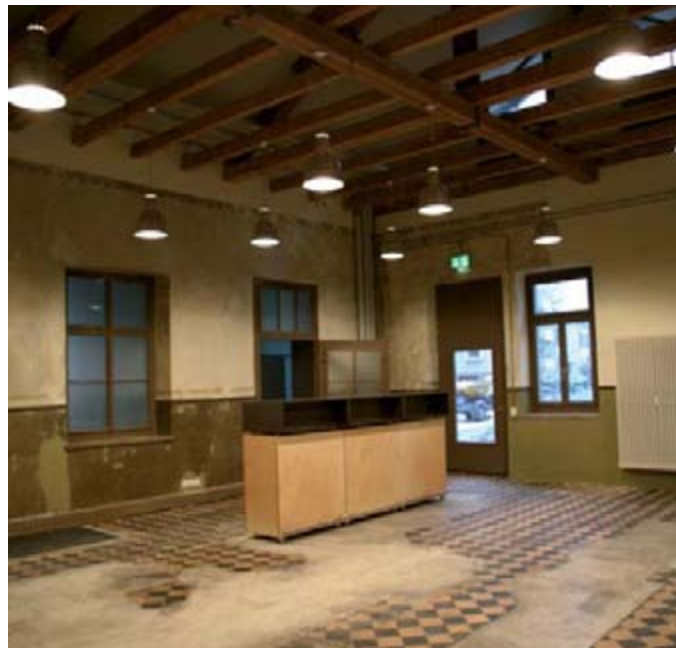
▲ In diesem ehemaligen Maschinenraum standen die Dampfmaschinen, welche die mechanischen Webstühle betrieben. | Foto: Dr. Hans-Peter Bärtschi
