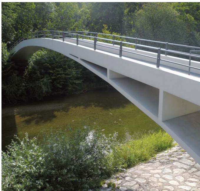
▲ Der Fussgängersteg bei der Schlosstalstrasse über die Töss wurde 1932 vom Ingenieur Walter Pfeiffer erstellt. | Foto: Denkmalpflege Stadt Winterthur
