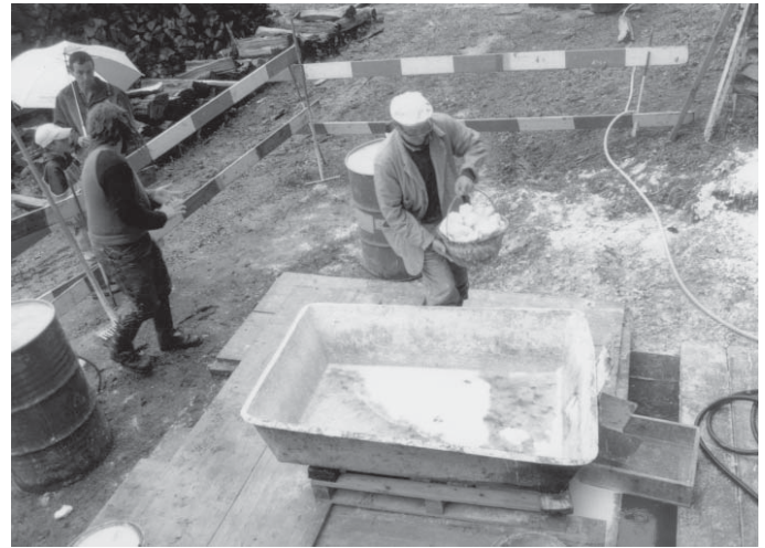
▲ 2. Gebrannter Kalk wird zum Löschen in eine Wanne geschüttet.
