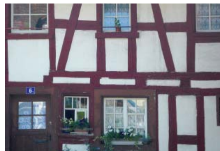
Riegelbau an der Riedhofstrasse.
