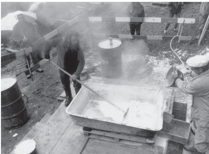
▲ 3. Löschen des gebrannten Kalks mit Wasser.
