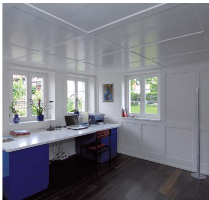
▲ Ehemalige Stube im Wohnteil des Bauernhauses. Zur Gewinnung von Raumhöhe wurde der Boden abgesenkt. | Foto: Karl Fülischer
