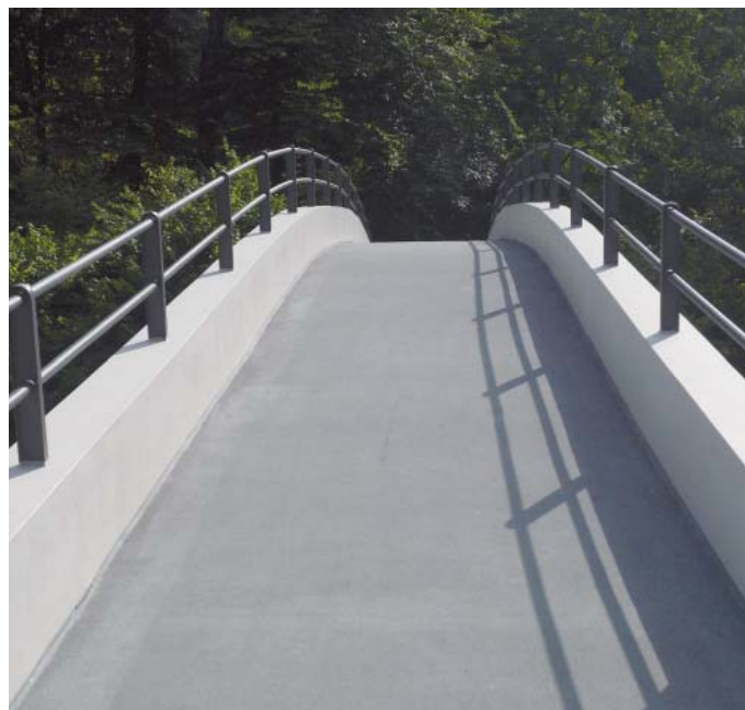
▲ Mit einem eleganten Schwung führt die Brücke von 1932 über die Töss. | Foto: Denkmalpflege Stadt Winterthur
