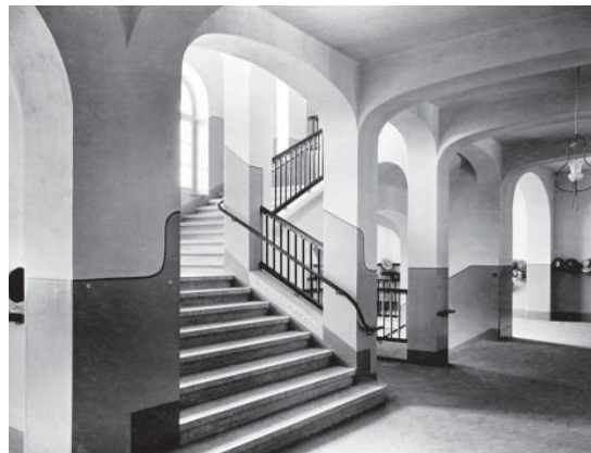
◀ Historische Aufnahme des Treppenhauses im Schulhaus an der Wülflingerstrasse, das 1905/1906 von Rittmeyer und Furrer erstellt worden ist. Foto: Sondersammlungen, Stadtbibliothek Winterthur
