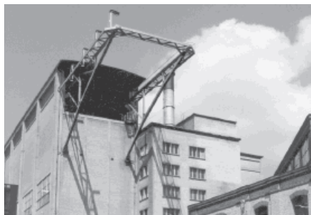
N: ehem. Grossgiesserei, Sulzer S: Gebäude Nr. 53 D: 1891 (Baubüro Sulzer; Bell, Kriens); Erweiterungen 1896 - 1906 (Baubüro Sulzer); Kopfbau Tössfeld 1927 (Baubüro Sulzer). B: Industriehalle; Backsteinbau mit grosszügigen Fensteröffnungen und monumentaler Fassadengliederung, dreischiffige "Industriekathedrale". Diese Monumentalhalle prägt sowohl den Eingang zum Katharina Sulzer-Platz von der Tössfeldstrasse her sowie den Platz selbst. Die Fassade zeichnet sich aus durch hohe, regelmässig sich wiederholende Backsteinfenster, die an die ägyptische Tempelbauweise erinnern. Der Katharina Sulzer-Platz war das Zentrum der Giesserei und des Sulzer-Areals überhaupt. ■
