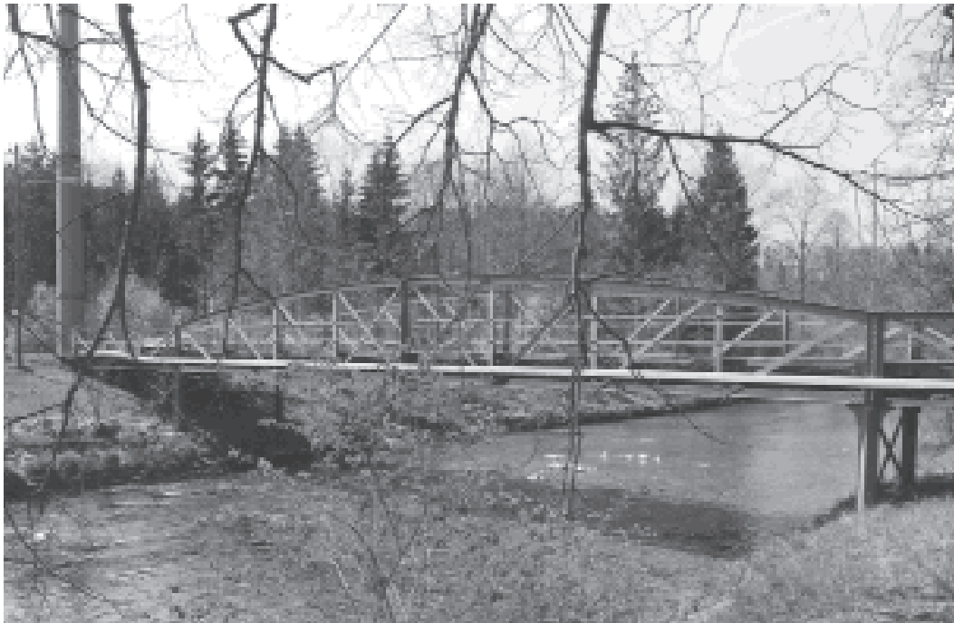
Eisenfachwerkbrücke bei Rämismühle, erbaut 1886 durch die Firma A. Bosshard in Näfels. Dieselbe Firma lieferte auch die Eisenbahnbrücken der Gotthardlinie und das Eisenskelett der Bundeshauskuppel in Bern.
