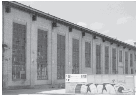
N: ehem. Grossgiesserei, Sulzer S: Gebäude Nr. 53 D: 1891 (Baubüro Sulzer; Bell, Kriens); Erweiterungen 1896 - 1906 (Baubüro Sulzer); Kopfbau Tössfeld 1927 (Baubüro Sulzer). B: Industriehalle; Backsteinbau mit grosszügigen Fensteröffnungen und monumentaler Fassadengliederung, dreischiffige "Industriekathedrale". Diese Monumentalhalle prägt sowohl den Eingang zum Katharina Sulzer-Platz von der Tössfeldstrasse her sowie den Platz selbst. Die Fassade zeichnet sich aus durch hohe, regelmässig sich wiederholende Backsteinfenster, die an die ägyptische Tempelbauweise erinnern. Der Katharina Sulzer-Platz war das Zentrum der Giesserei und des Sulzer-Areals überhaupt. ■
