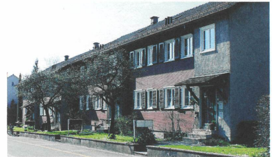
Strassenfassade einer Häuserreihe vor der Sanierung durch Isler Architekten mit Eternitschindeln, 2017
