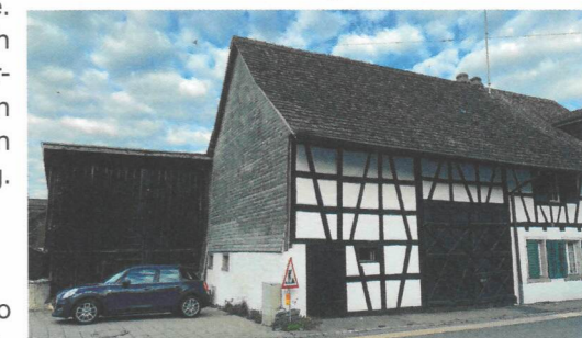
Wohnhaus mit Scheune und Schopf-Anbau vor dem Umbau, 2020
