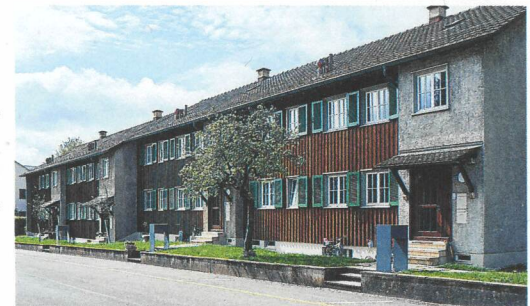
Strassenfassade einer Häuserreihe nach der Sanierung mit wiederhergestellter vertikaler Holzverschalung nach bauzeitlichem Vorbild, 2023
