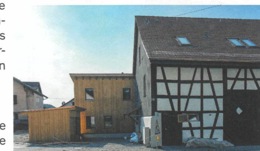
Wohnhaus mit neuem Anbau an den Scheunenteil und ergänztem Unterstand, 2023
