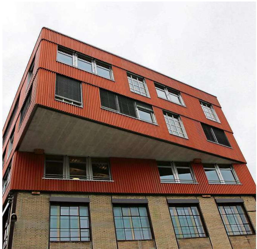
Das Gebäude K118 befindet sich auf dem Sulzerareal.
