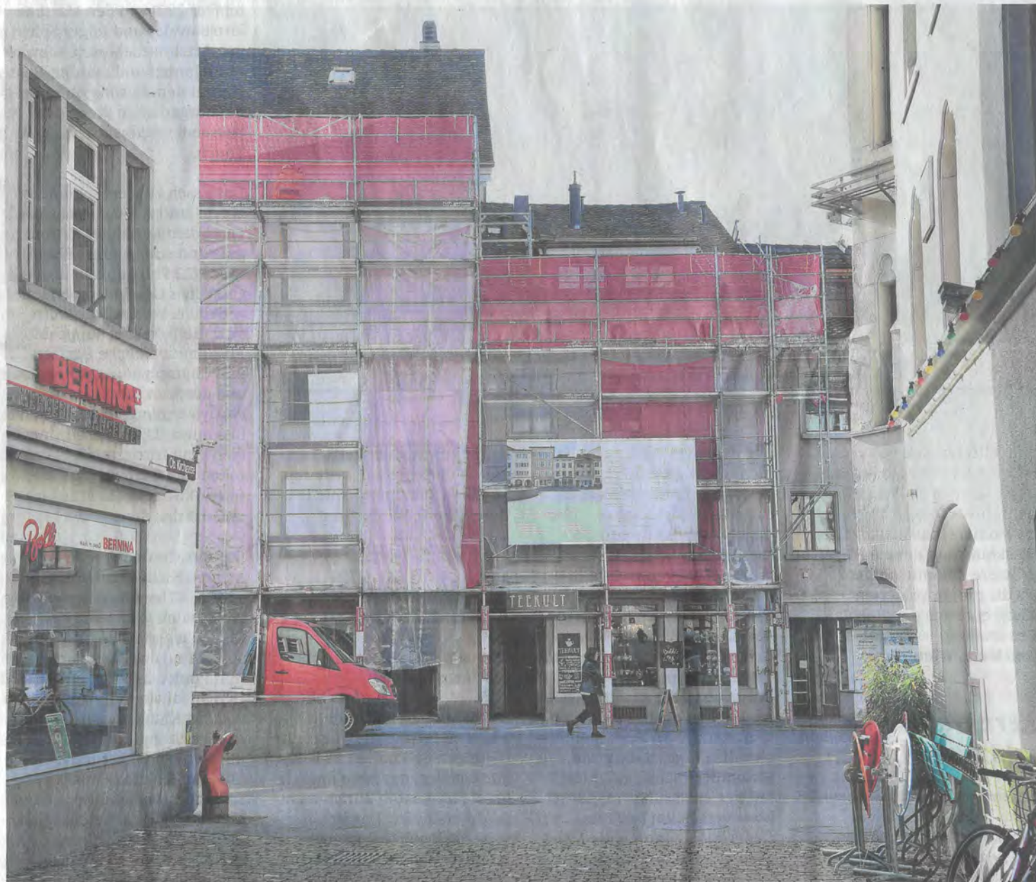
Etwa 2,6 Millionen Franken steckt Terresta in die Renovierung der zwei rund 400 Jahre alten Häuser. Foto: Madeleine Schoder
