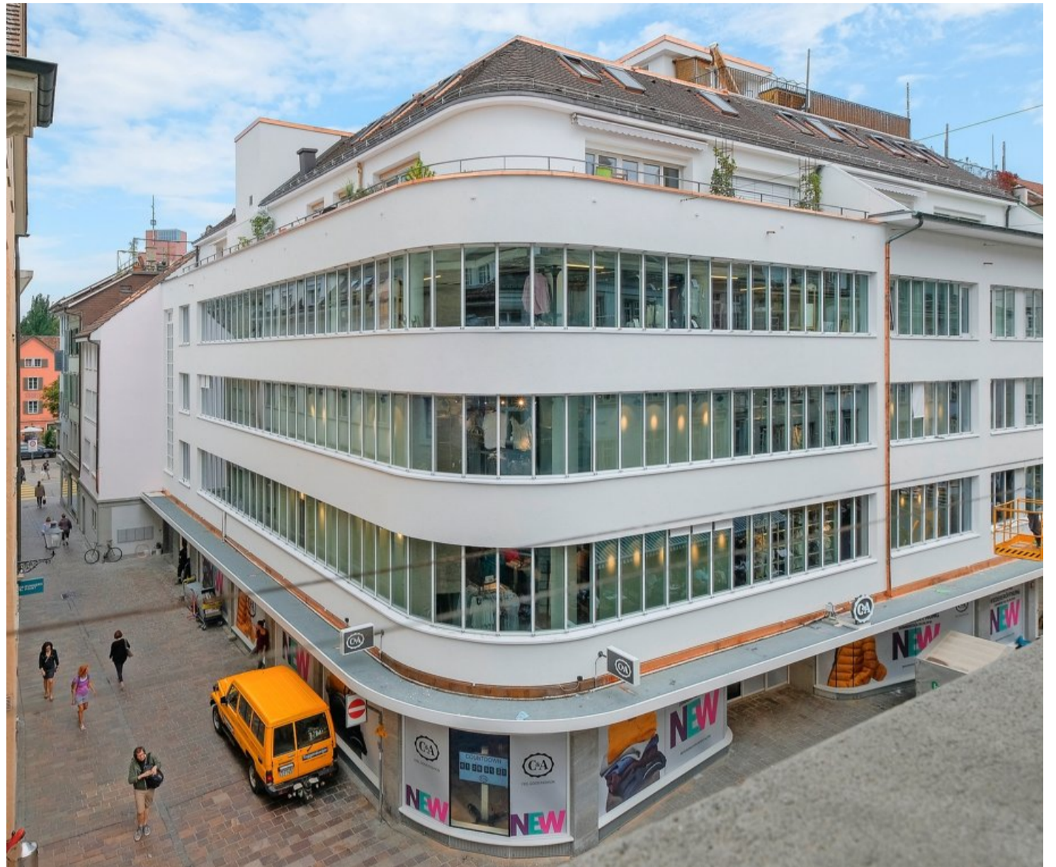
Das renovierte C&A-Gebäude kurz vor der Neueröffnung des Kleiderhauses.
