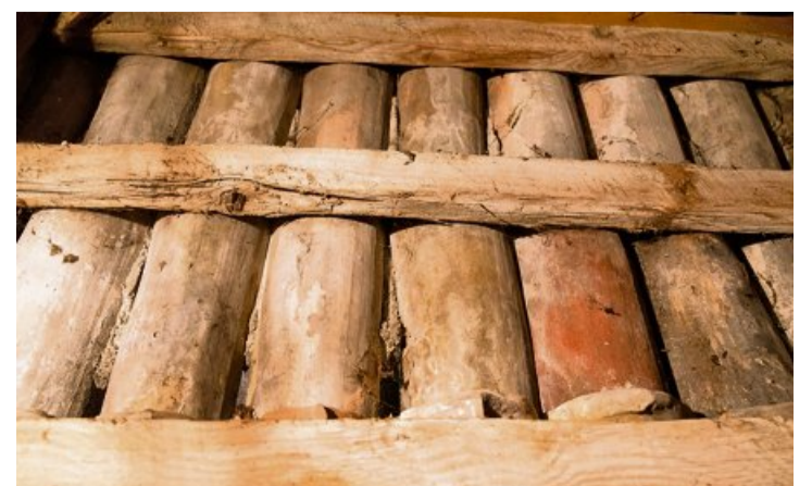
Diese uralten Holzbalken tragen die Dachziegel.
