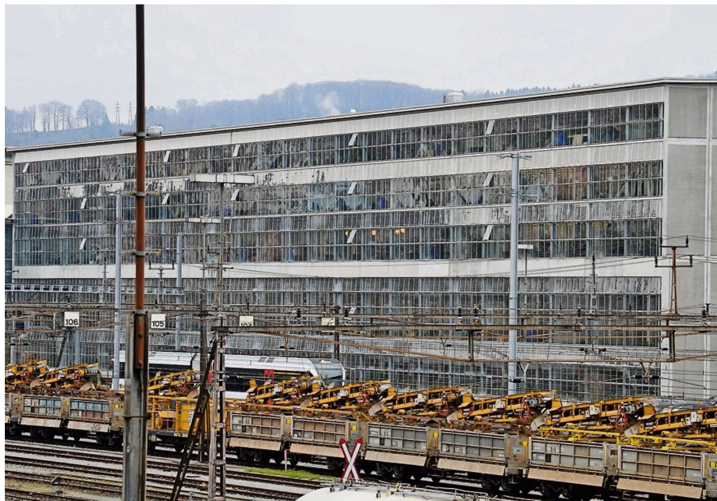
Die Halle 181 wurde aufgestockt und zu den Gleisen hin mit einer vorgelagerten Gewächshausfassade versehen.
