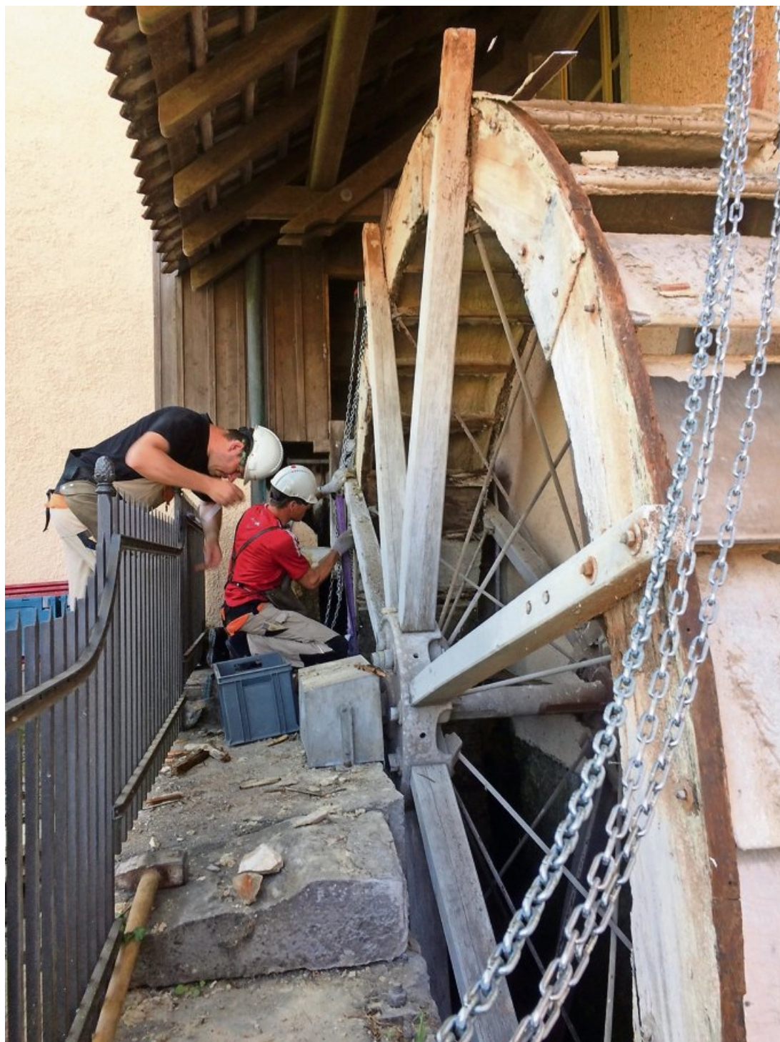
Mitarbeiter der Wagnerei Oehrli zerlegen das Mühlrad der Lindenmühle aus dem Jahr 1981.
