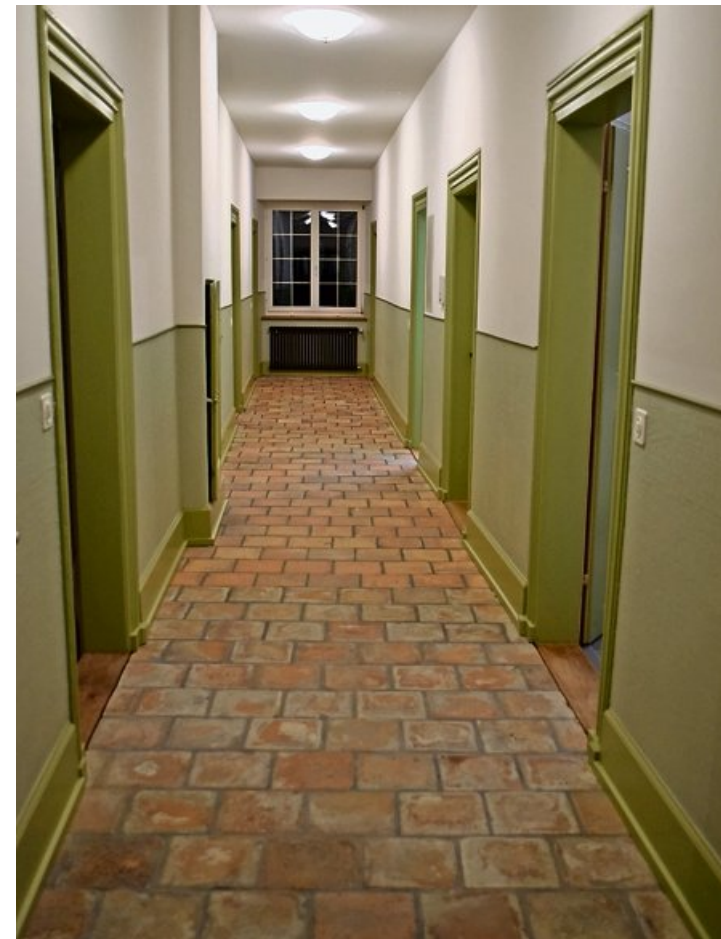
Der alte Tonboden lag unter mehreren Belagschichten versteckt. Evi Biedermann
