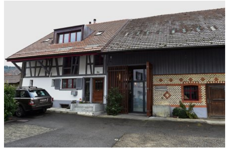
Der Haupteingang im ehemaligen Tenn ist auch eine Schmutzschleuse.
