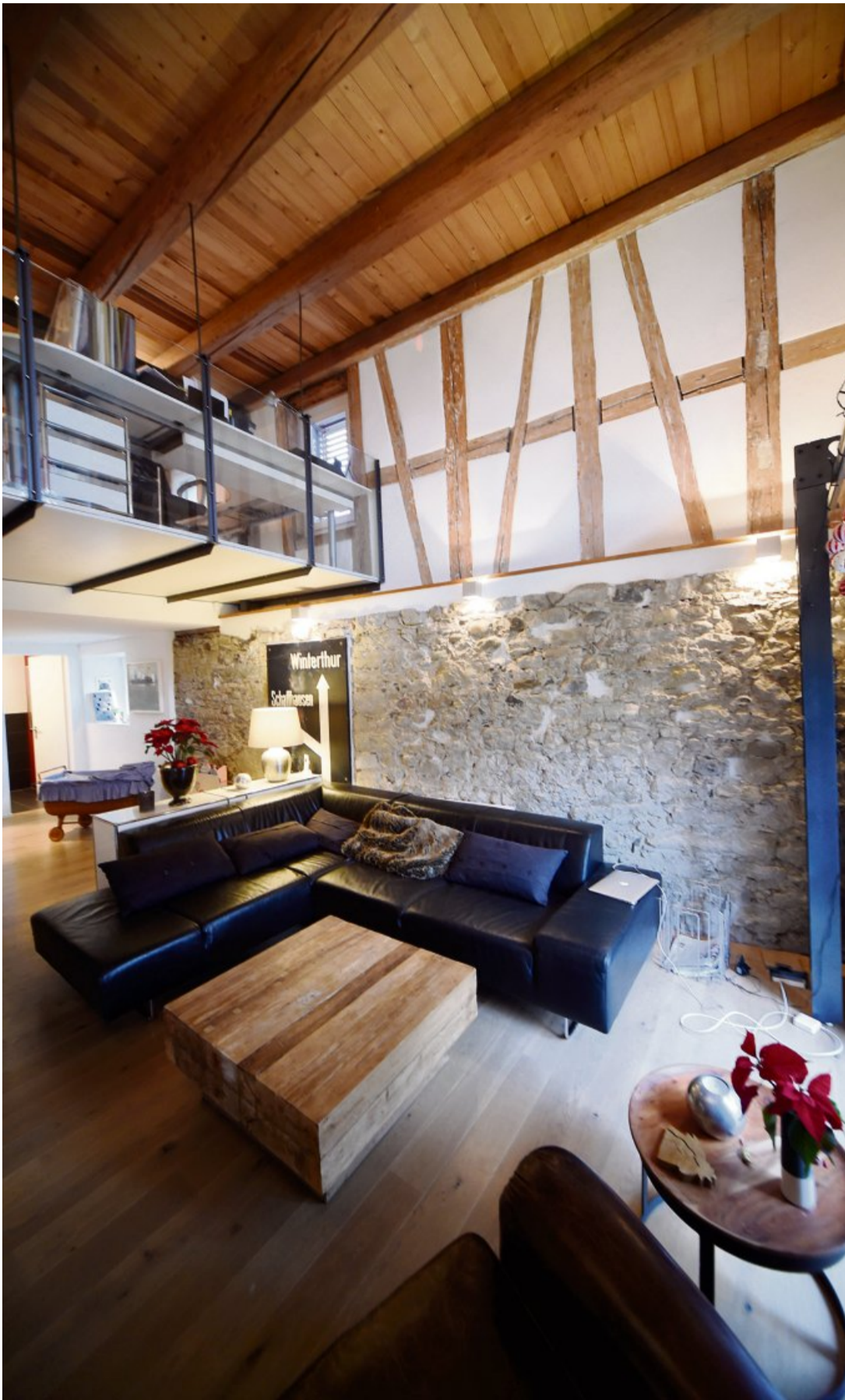
Der Wohnbereich mit Galerie, die platzsparend an der Dachkonstruktion aufgehängt wurde.
