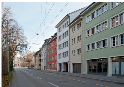
Sanierte Häuserzeile an der Stadthausstrasse
