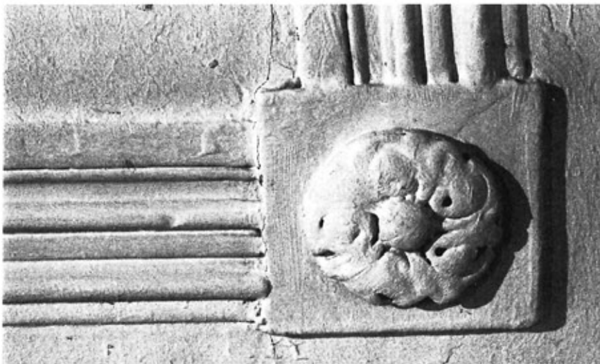
Ausschnitt der überdeckten Gipsdecke
