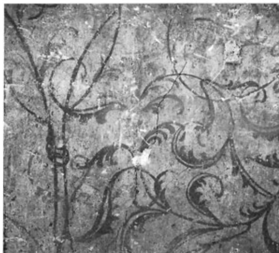
Rankenmalerei aus dem 16. Jahrhundert in der Stube des 1. Obergeschosses.
