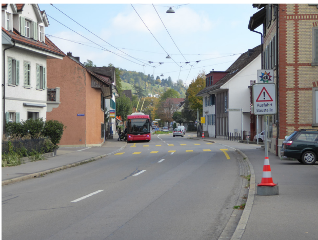
Abbildung 7: Wüflingerstrasse, Höhe Einfahrt Coop-Parkhaus
