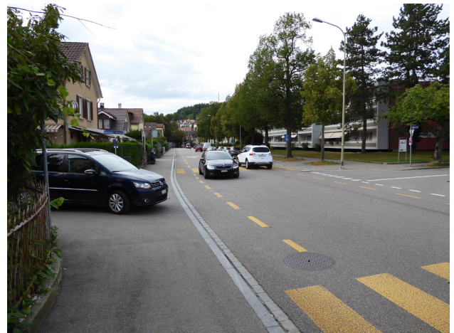
Abbildung 6: Knoten Untere Briggerstrasse / Agnesstrasse Eingeschränkte Sicht für die einmündende Agnesstrasse und fehlende Schutzinseln an den Fussgängerstreifen.
