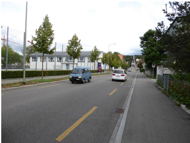
Abbildung 7: Untere Briggerstrasse, Höhe Schulhaus und Sportanlage Tössfeld Gestreckte Linienführung und die Markierung der Radstreifen ziehen den Blick in die Tiefe zur Storchenbrücke. Die Aufmerksamkeit ist dadurch ggf. auf querende Fussgänger (Schüler, Kinder) oder von den Grundstücken ausfahrende Fahrzeuge vermindert. Die effektiv gefahrenen Geschwindigkeiten liegen gemäss Messung bei rund 47 km/h (v85).
