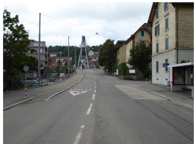
Abbildung 12: Untere Briggerstrasse vor Storchenbrücke Nach der Tössfeldstrasse wirkt der angrenzenden Strassenraum weniger «aufgeräumt». Der Fahrbahnzustand und die angrenzende Bebauung sind in einem optisch schlechteren Zustand als im Abschnitt zur Zürcherstrasse. Das Velo wird gemeinsam mit den Fussgängern abseits der Fahrbahn geführt.
