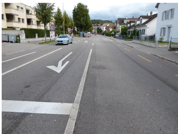
Abbildung 3: Untere Briggerstrasse / Zürcherstrasse Zwischen Zürcher- und Agnesstrasse bestehen 9 Grundstückszufahrten auf beiden Seiten der Briggerstrasse. Die Sicht ist teilweise durch Mauern, Bepflanzung oder parkierte Fahrzeuge der blauen Zone eingeschränkt.
