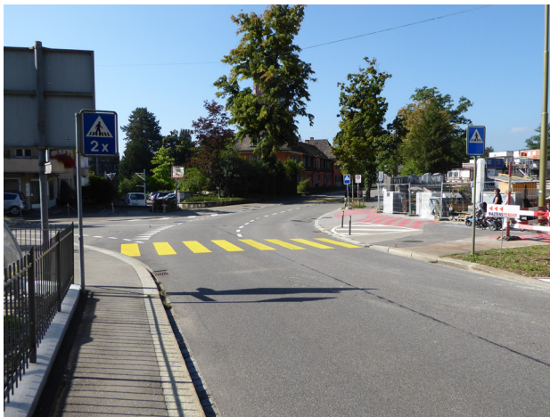
Abbildung 7: Haldenstrasse / Albanistrasse IG.-Keller-Strasse Eingeschränkte Begreifbarkeit der Kreuzung mit fünf Knotenarmen, einer Grundstückszufahrt und einem Fussgängerstreifen ohne Schutzinsel. Die Spitalzufahrt wird mit dem Neubau neugeregelt und mündet nicht mehr in den gleichen Knoten.
