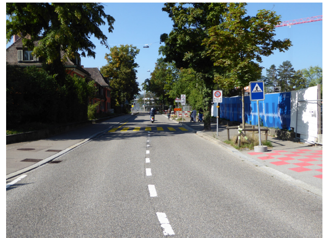
Abbildung 8: Haldenstrasse, Zufahrt auf Knoten Lindstrasse Eingeschränkte Erkennbarkeit des Fussgängerstreifens ohne Schutzinsel «im Schatten» der Alleebäume. Auf dem (nahezu) gesamten Abschnitt der Haldenstrasse ist keine Veloinfrastruktur vorhanden.
