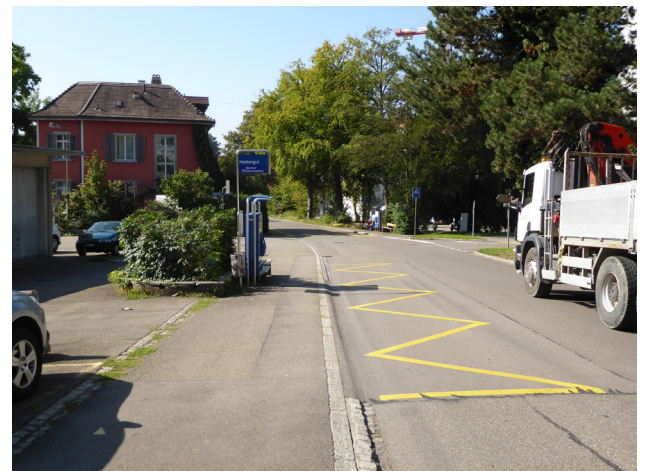
Abbildung 4: Haldenstrasse, Haltestelle Haldengut Erkennbarkeit Situation durch Überlagerung von Grundstückszufahrten, Bushaltestelle, Einmündung Brauerstrasse und Notfallzufahrt Spital (rechts) und Einmündung Brauerstrasse mit Trottoirüberfahrt (links) eingeschränkt.
