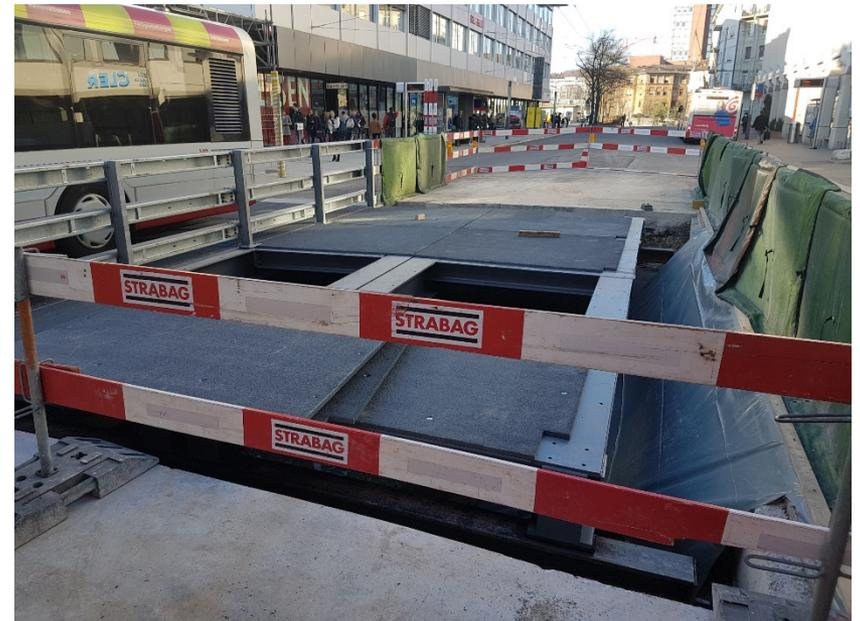
Bushilfsbrücken wurden für einen durchgehenden Busbetrieb eingebaut
