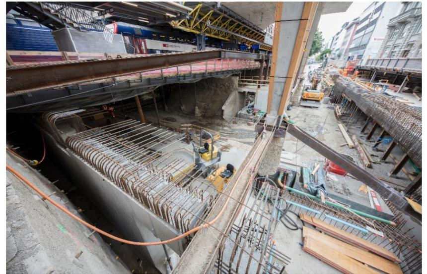
Betonarbeiten unter den Gleisen und Parkhausrampe.
