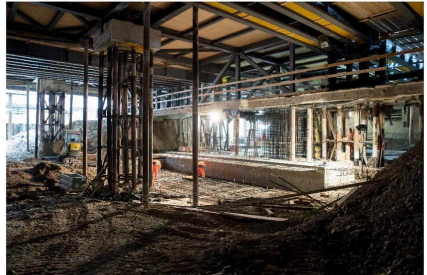
Aushub und Betonarbeiten an der neuen Unterführung und Veloquerung.
