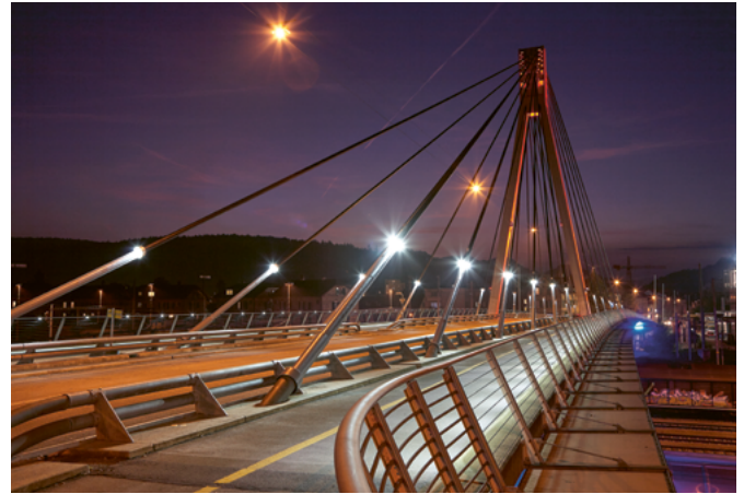
Neue Lichtinstallation Storchenbrücke, 2009 Foto: Markus Ronner
