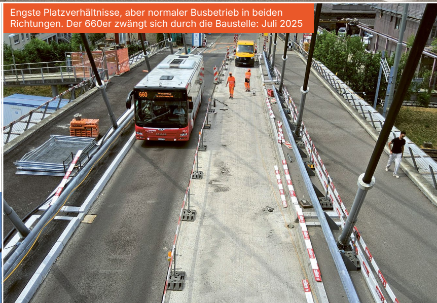
Die rund vier Meter über der Fahrbahn angebrachte Plattform dient als Sicherheitsmassnahme für die Höhenarbeiten: Juni 2025
