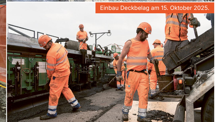
Passt die Maschine genau auf die Strasse oder passt die Strasse genau zur Maschine? Einbau des definitiven Deckbelags.
