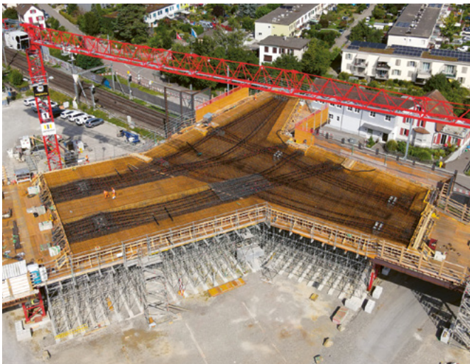
Im Bild gut sichtbar: die Rohre der Vorspannkabel. Diese erhöhen die Tragkraft der Brücke und ermöglichen einen schlanken Brückenkörper.
