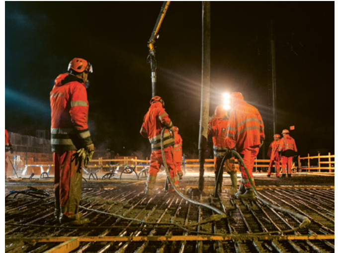
Das Betonieren erfolgte im Mehrschichtbetrieb von Dienstagnacht bis am Mittwochnachmittag im Zweischichtbetrieb.
