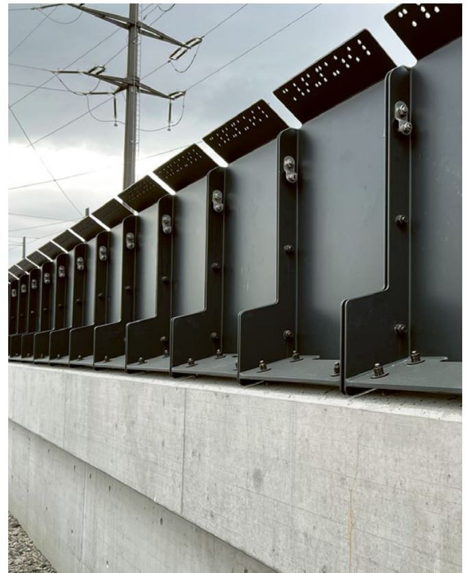
Aussenansicht des Geländerbands bei der Rampe zur Sulzerallee
