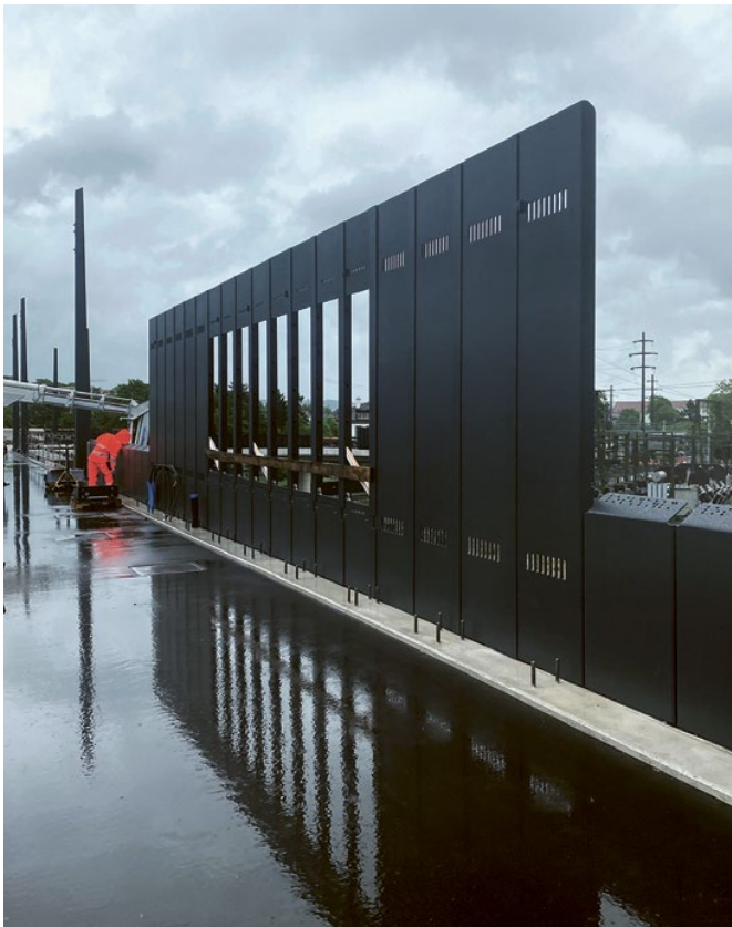
April 2026: Wartehalle im Aufbau
