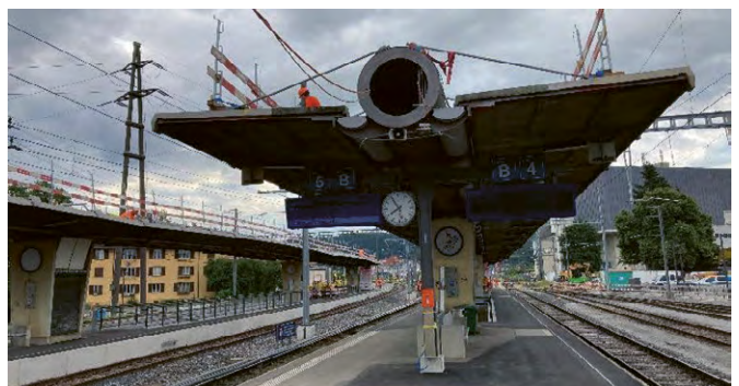
Perrondächer während der aktuellen Sanierung. Bild: SBB
