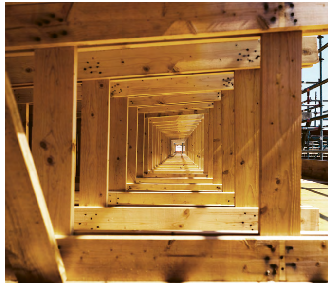
Detail des Lehrgerüsts über den Gleisen.
