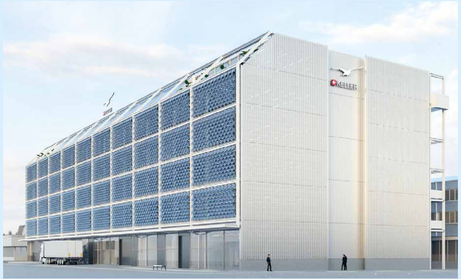
Das neue Produktionsgebäude «Diamant» (Bilder: KELLER Druckmesstechnik)
