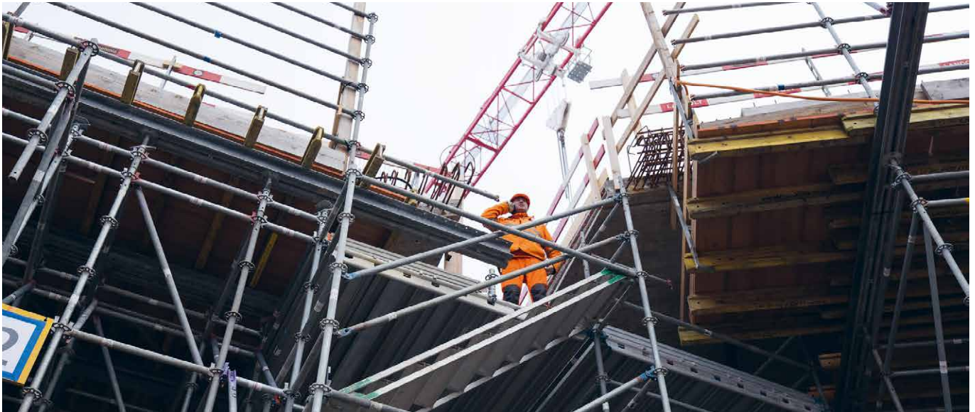
Behält die Übersicht: Chefpolier Beat Klaus auf der Baustelle der Querung Grüze (Bilder: Jantofilm)
