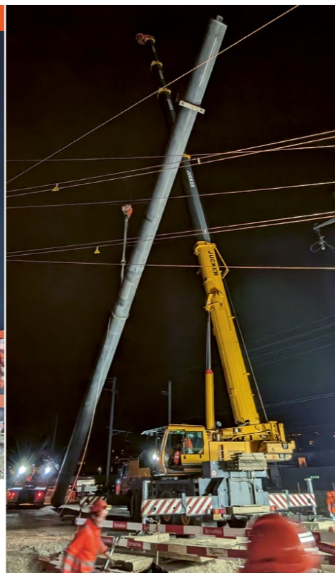
Pressbohrung unter der Frauenfelder Linie
