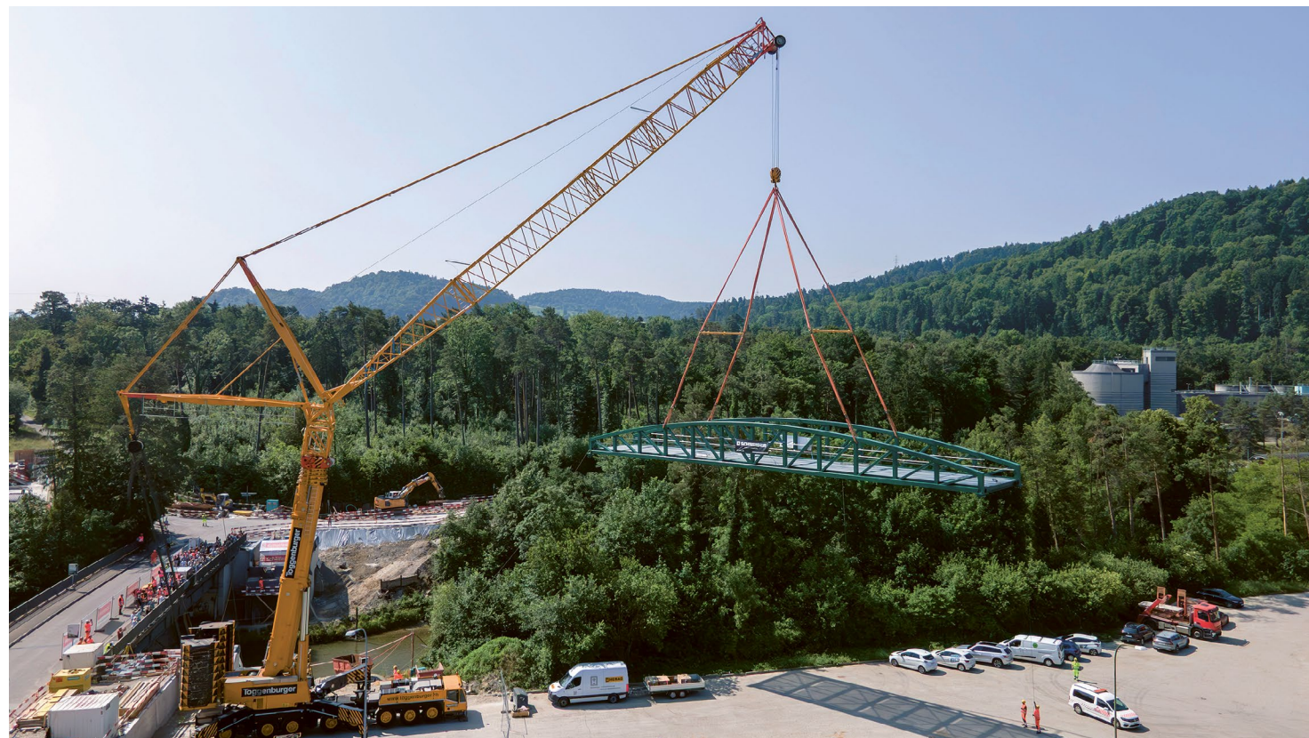
42 Tonnen schweben in der Luft.
