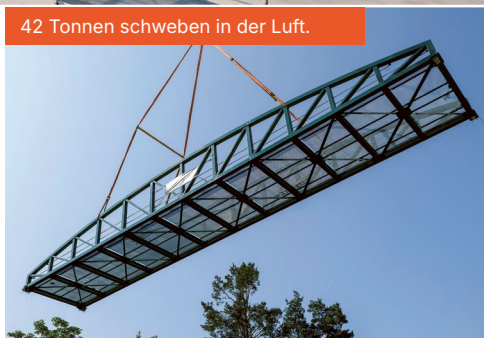
Korrekturen im Millimeterbereich vor dem Absetzen
