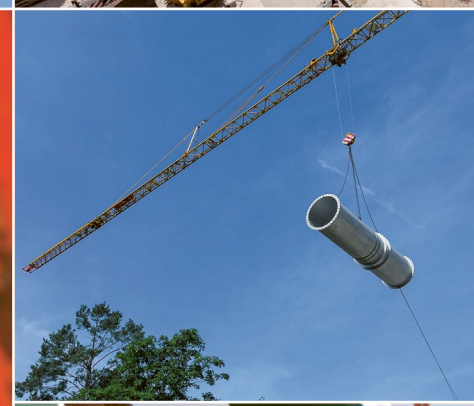
Die Rohrleitung hat einen Durchmesser von 1,40 Metern.
